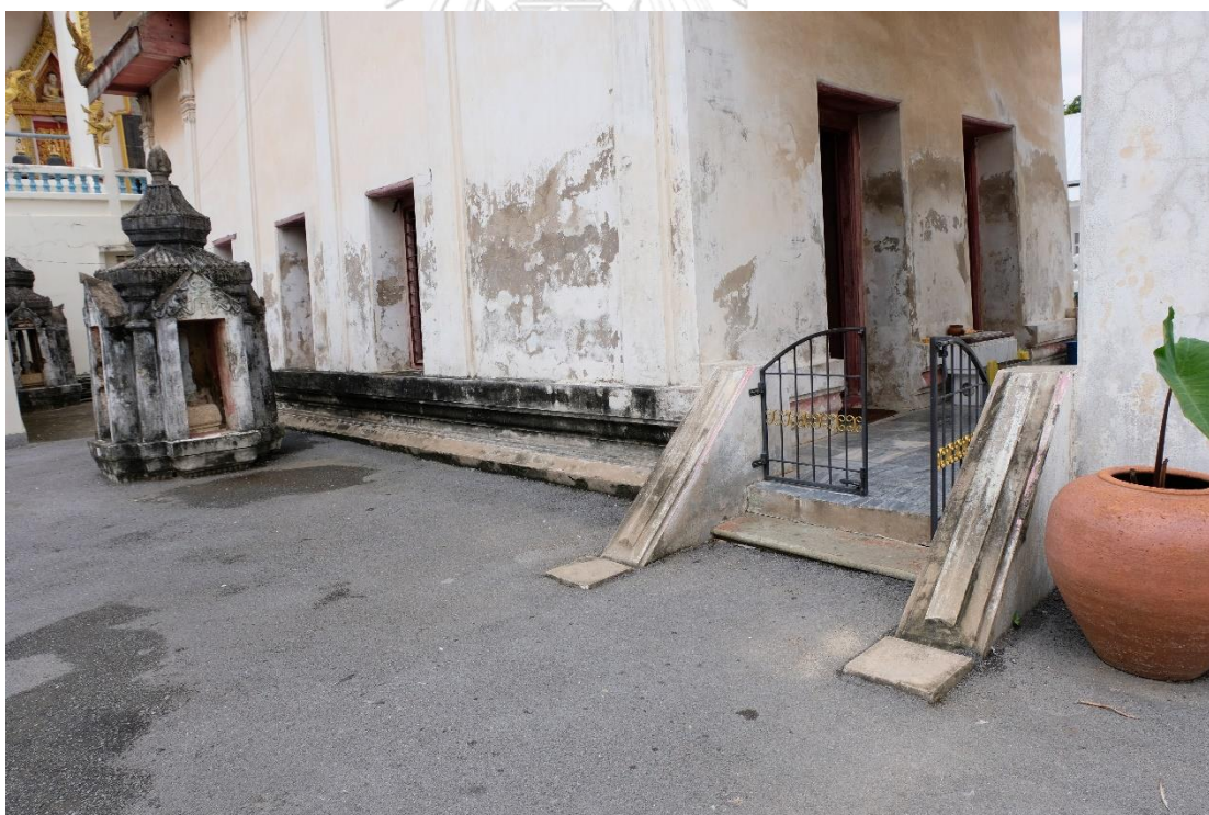
รูปที่ 4-24 ระดับพื้นเดิมของวัดบางระโห่งอยู่ต่ำกว่าระดับพื้นปัจจุบันประมาณ 40 เซนติเมตร
