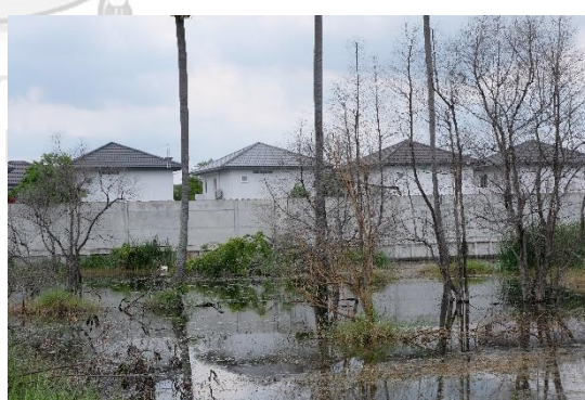
รูปที่ 4-28 รั้วกำแพงกันดินล้อมรอบโครงการหมู่บ้านจัดสรร
