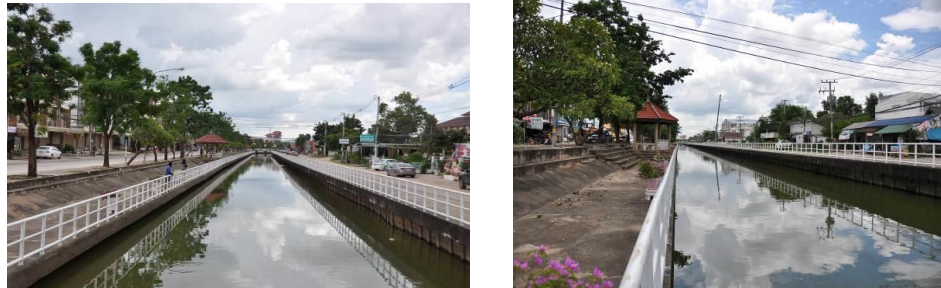
รูปที่ 4-35 สภาพปัจจุบันคลองสมถวิล ย่านที่ 4 ร้านค้าและสถานบันเทิง ที่มา: โดยผู้วิจัย (อ้างอิงจากการลงพื้นที่สำรวจเมื่อวันที่ 15 สิงหาคม 2560)
