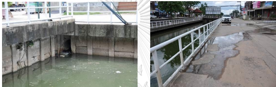
รูปที่ 4-36 แสดงการระบายน้ำทิ้งจากอาคารบ้านเรือน ที่มา: โดยผู้วิจัย (อ้างอิงจากการลงพื้นที่สำรวจเมื่อวันที่ 15 สิงหาคม 2560)
