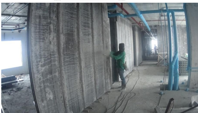
รูปที่ 4.10 การเจาะผนัง และใส่เหล็กเสริมระหว่างรอยต่อของผนัง
