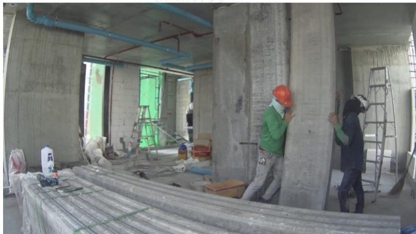
รูปที่ 4.7 การยกติดตั้งแผ่นผนัง
