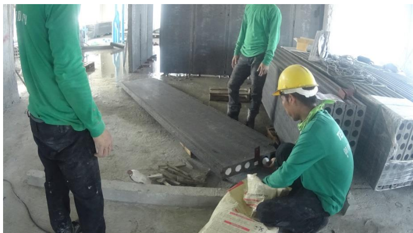
รูปที่ 4.5 การติดตั้งโฟม และเหล็กฉากด้านบนของแผ่นผนัง
