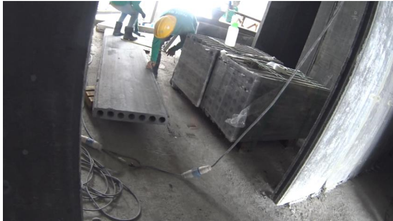
รูปที่ 4.3 การวัดขนาดแผ่นผนัง
