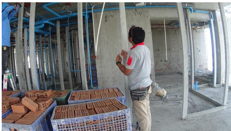
รูปที่ 4.31 การขึงเอ็นเพื่อกำหนดแนวก่อ (อิฐมวลเบา)
