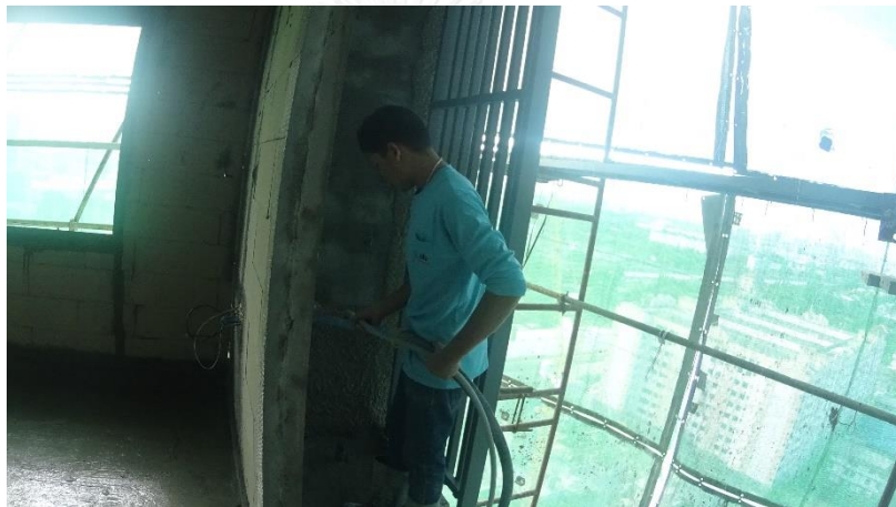
รูปที่ 4.24 การพ่นปูนฉาบ (อิฐมวลเบา)
