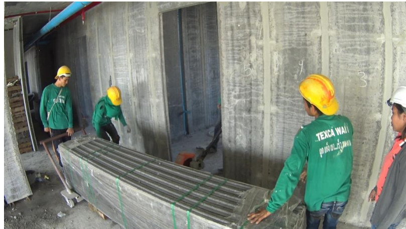
รูปที่ 4.1 การเคลื่อนย้ายแผ่นผนังคอนกรีตมวลเบา
