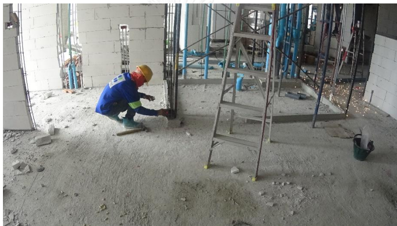
รูปที่ 4.19 การชิงเอ็นเพื่อกำหนดแนวก่อ (อิฐมวลเบา)
