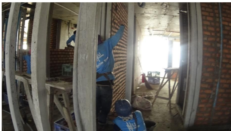
รูปที่ 4.32 การเสียบเหล็กหนวดกุ้ง (อิฐมอญ)
