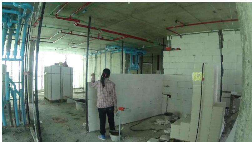
รูปที่ 4.20 การก่ออิฐ (อิฐมวลเบา)
