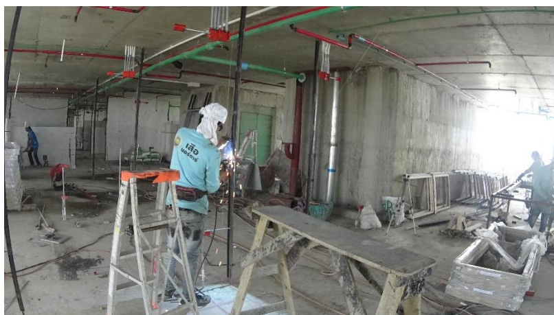
รูปที่ 4.17 การเชื่อมเหล็กหนวดกุ้ง (อิฐมวลเบา)
