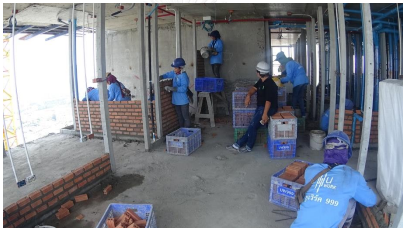
รูปที่ 4.35 การก่ออิฐ (อิฐมอญ)
