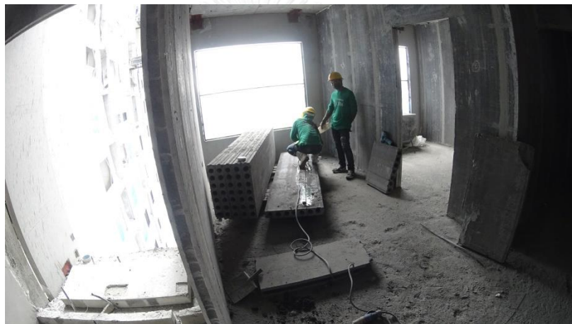
รูปที่ 4.4 การตัดแผ่นผนัง
