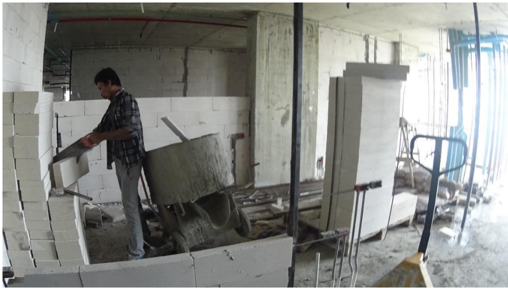
รูปที่ 5.27 การใช้เลื่อยในการผ่าอิฐ
