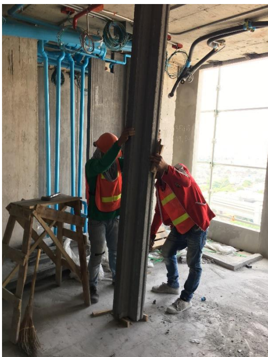
รูปที่ 5.2 (ก) แผ่นผนังรูปตัว T
