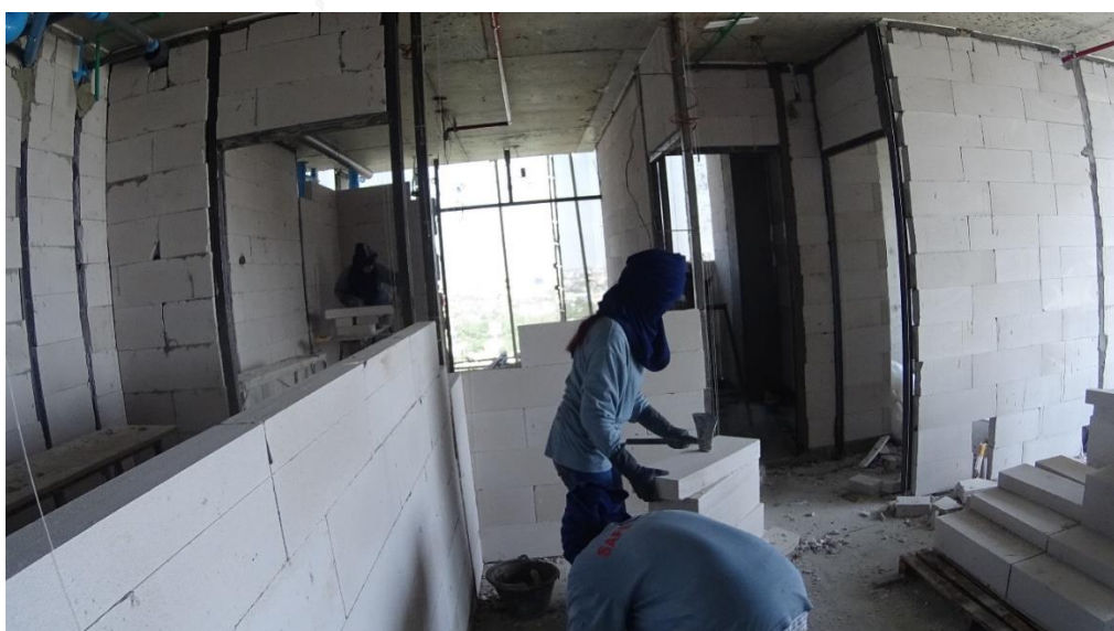
รูปที่ 5.28 การใช้ขวานในการผ่าอิฐ
