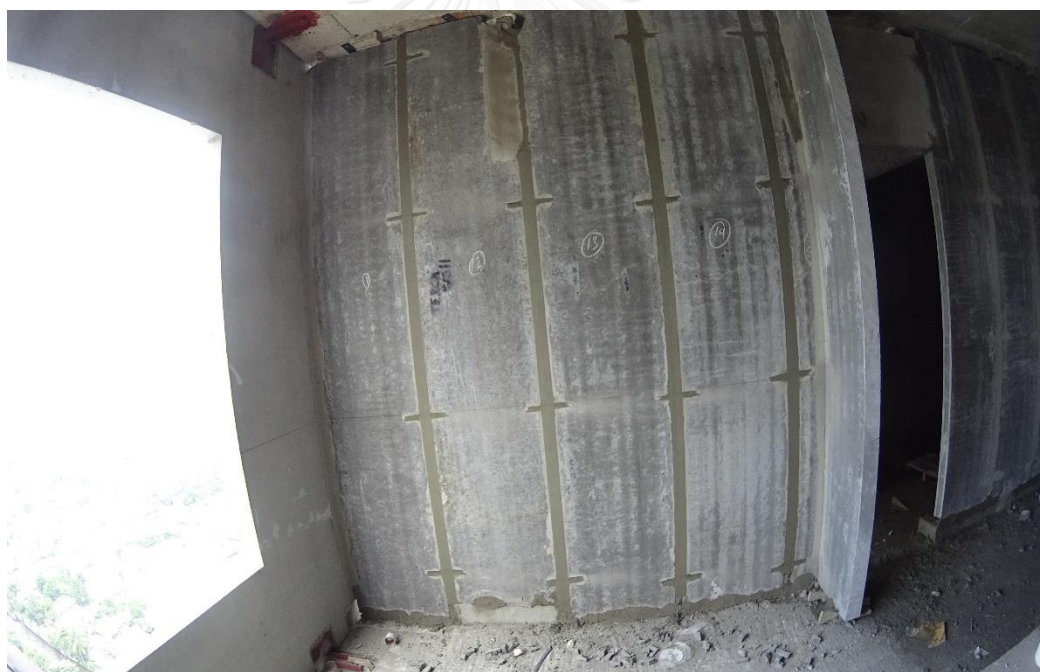
รูปที่ 5.25 การใส่เหล็กเชียวคีย์ในในกรณีศึกษาหลักกระบวนการก่อสร้างผนังคอนกรีตมวลเบา
