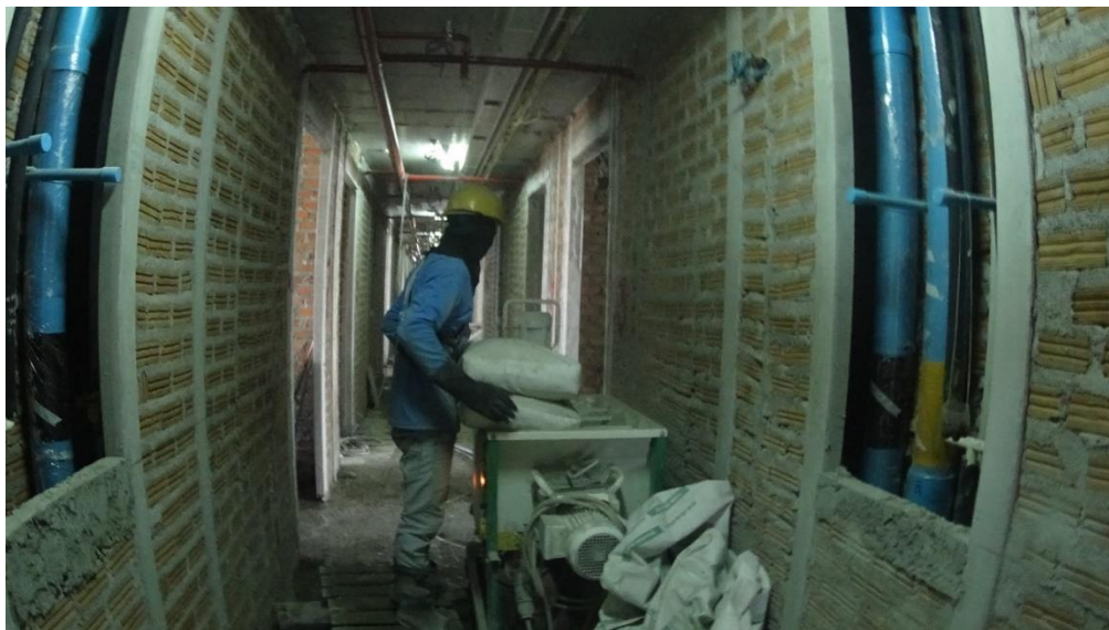
รูปที่ 5.31 การผสมปูนฉาบจากปูนสำเร็จรูปประเภทบรรจุถุง
