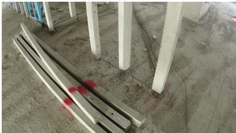
รูปที่ 4.30 เสาเอ็นสำเร็จรูปประเภทคอนกรีต (อิฐมวลเบา)
