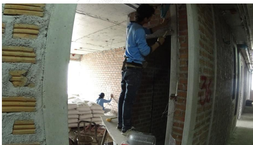
รูปที่ 4.38 การติดตาข่าย (อิฐมอญ)
