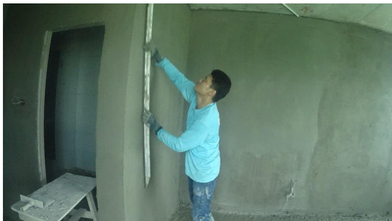
รูปที่ 4.25 การฉาบผนัง (อิฐมวลเบา)
