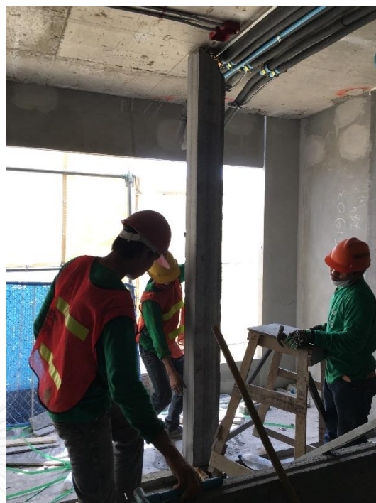
รูปที่ 5.2 (ข) แผ่นผนังรูปตัว L
