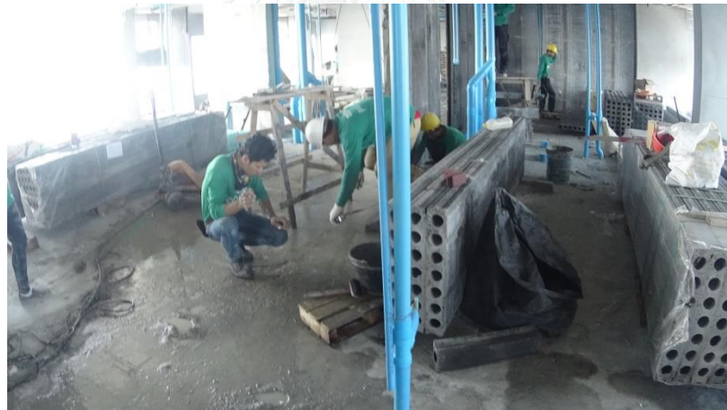
รูปที่ 4.2 การกำหนดแนวติดตั้งผนัง
