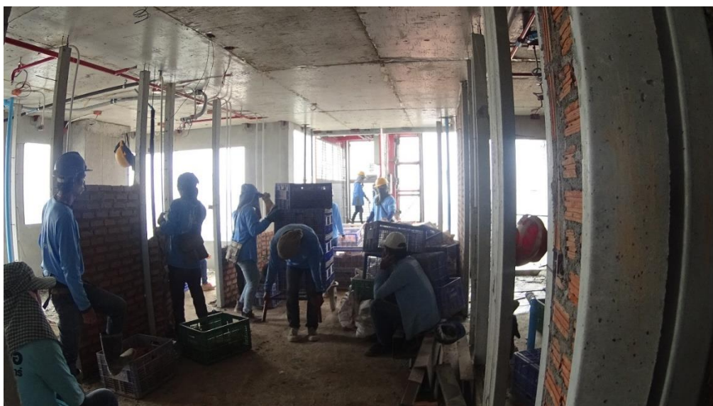
รูปที่ 5.29 การเคลื่อนย้ายอิฐมอญ
