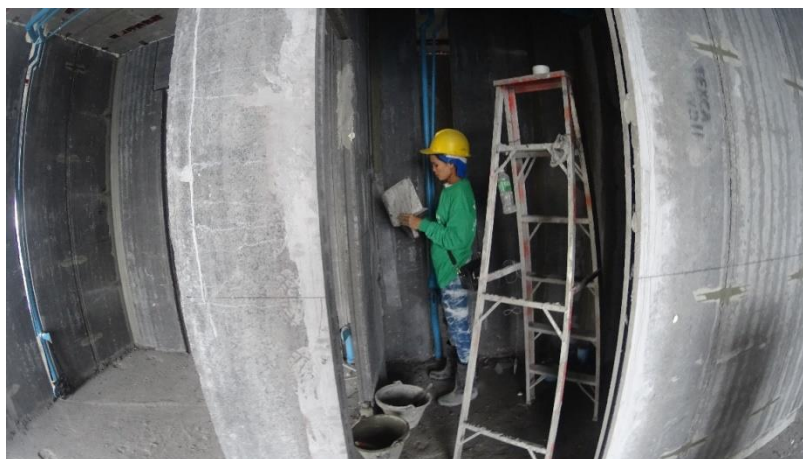
รูปที่ 4.9 การติดตาข่ายไฟเบอร์ระหว่างรอยต่อของแผ่นผนัง
