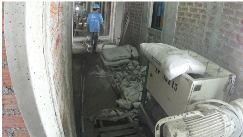
รูปที่ 4.40 เครื่องผสม และพ่นปูน (อิฐมวลเบา)
