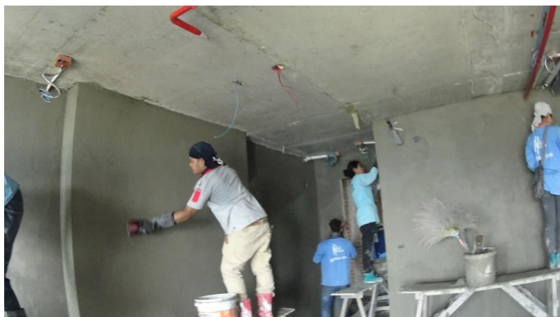
รูปที่ 4.41 การฉาบปูน (อิฐมวลเบา)
