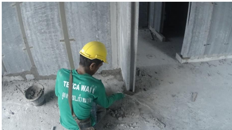
รูปที่ 4.11 การอุดช่องว่างระหว่างผนังกับพื้นด้านล่างด้วยปูนก่อ
