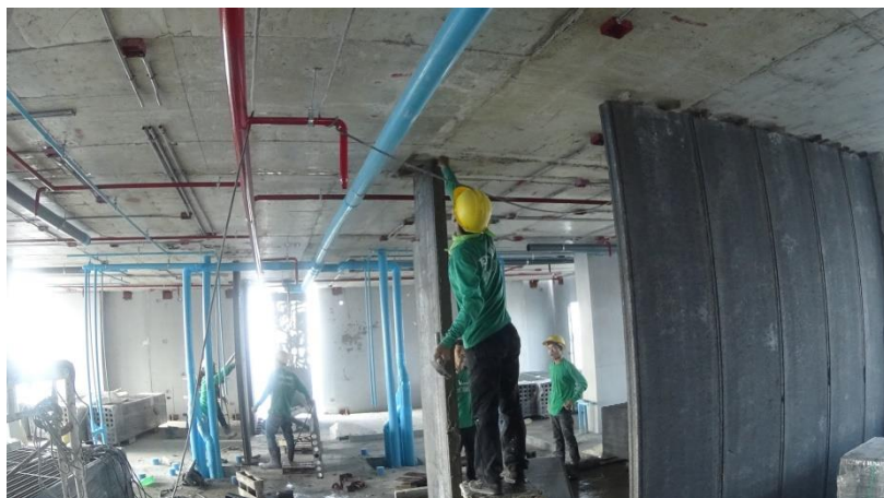
รูปที่ 4.8 การตอกลิ้มยึดแผ่นผนัง
