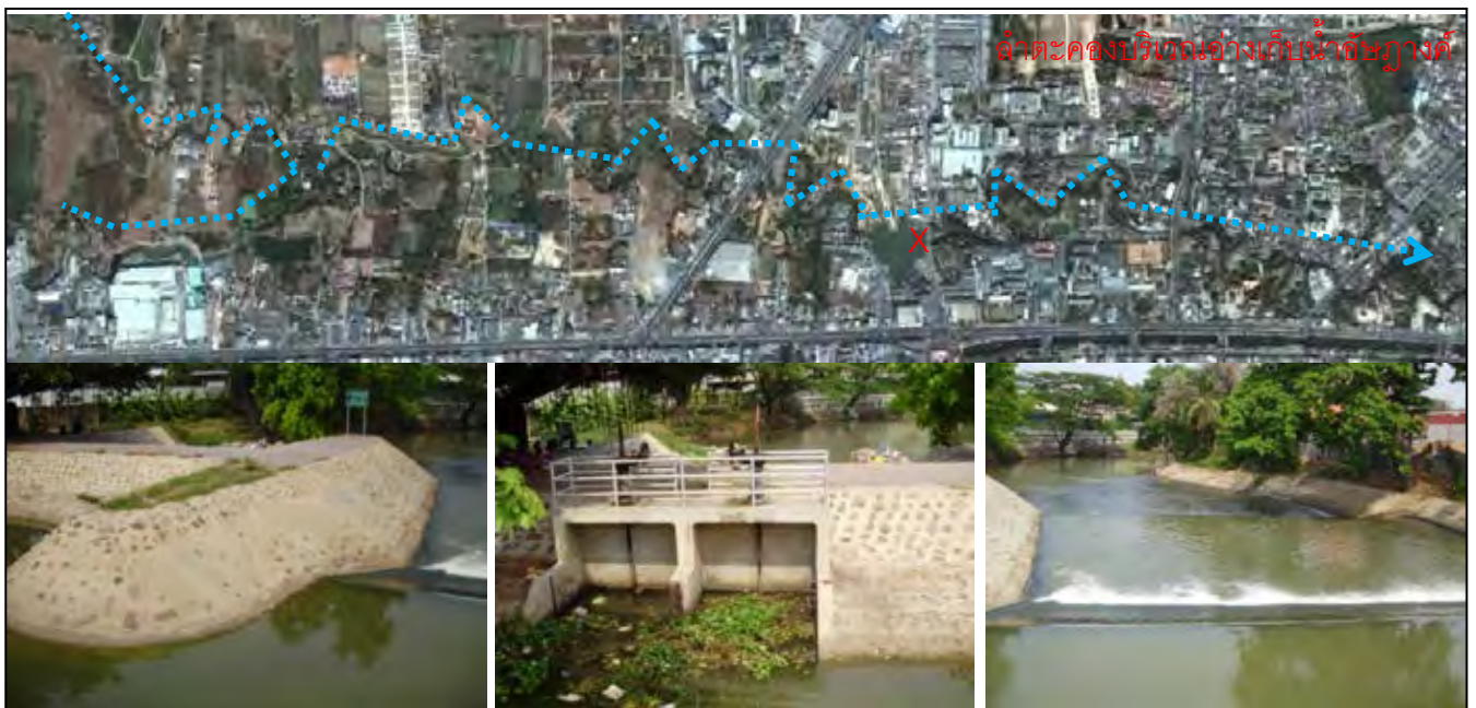
ภาพที่ 5.7 ลำน้ำลำตะคองมีสร้างฝายขวางกั้นลำน้ำเพื่อการเก็บกักน้ำไว้ทำน้ำประปา
