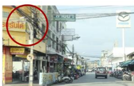
ภาพที่ 5 การติดตั้งกล้องวงจรปิด
