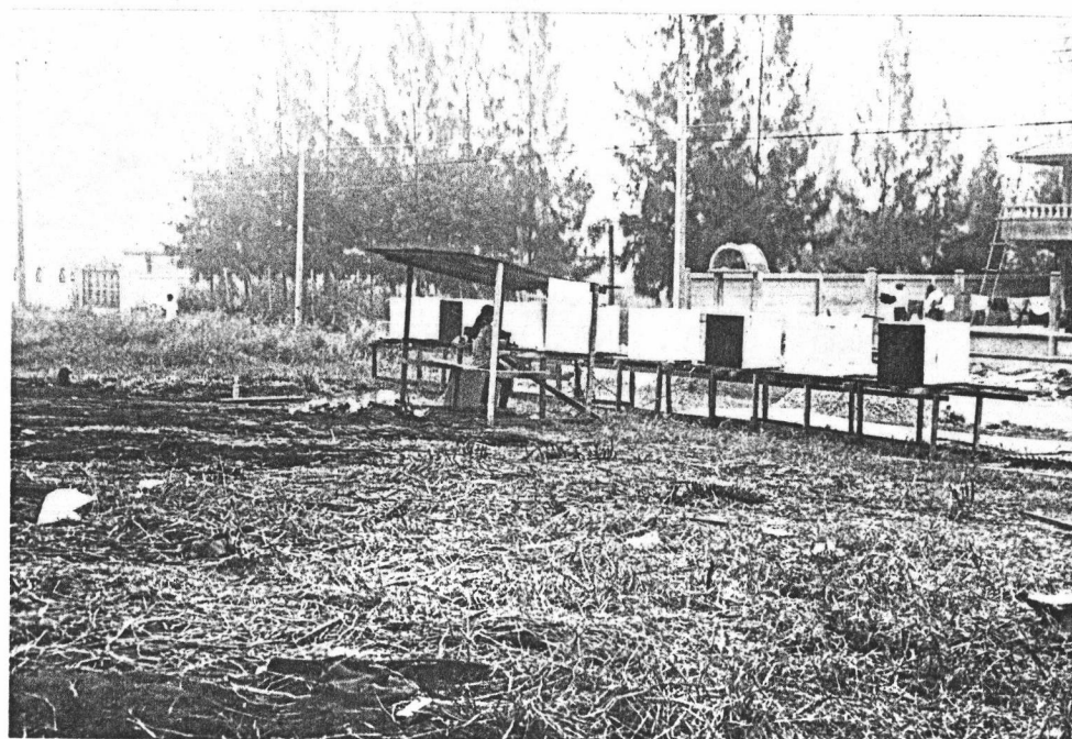
รูปที่ 5 แสดงการวางกล่องทดสอบบนชั้นวางกล่อง เพื่อกัน MRT จากดิน ถ่ายจากสถานที่ทดสอบ
