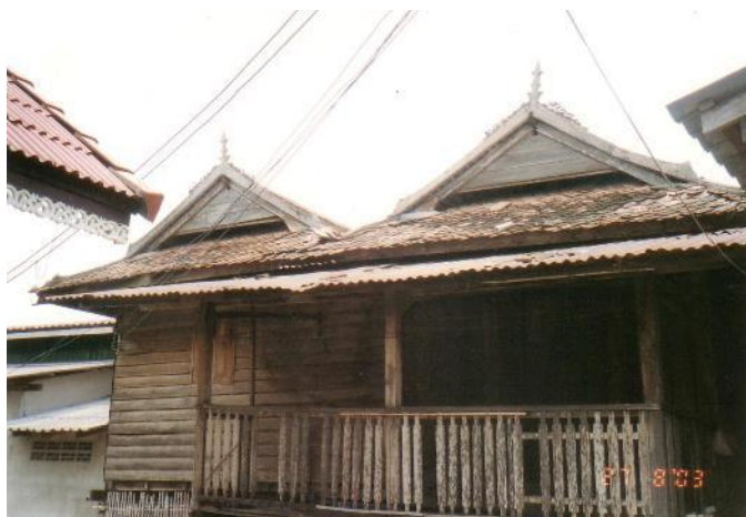
รูปที่ 32 หลังคาจั่วมนิลา หรือ หลังคาบลานอ
