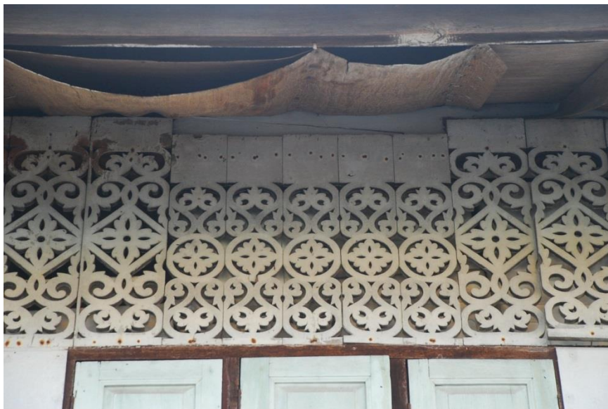
รูปที่ 5 ลวดลายช่องลมที่พบในสามจังหวัดชายแดนภาคใต้
