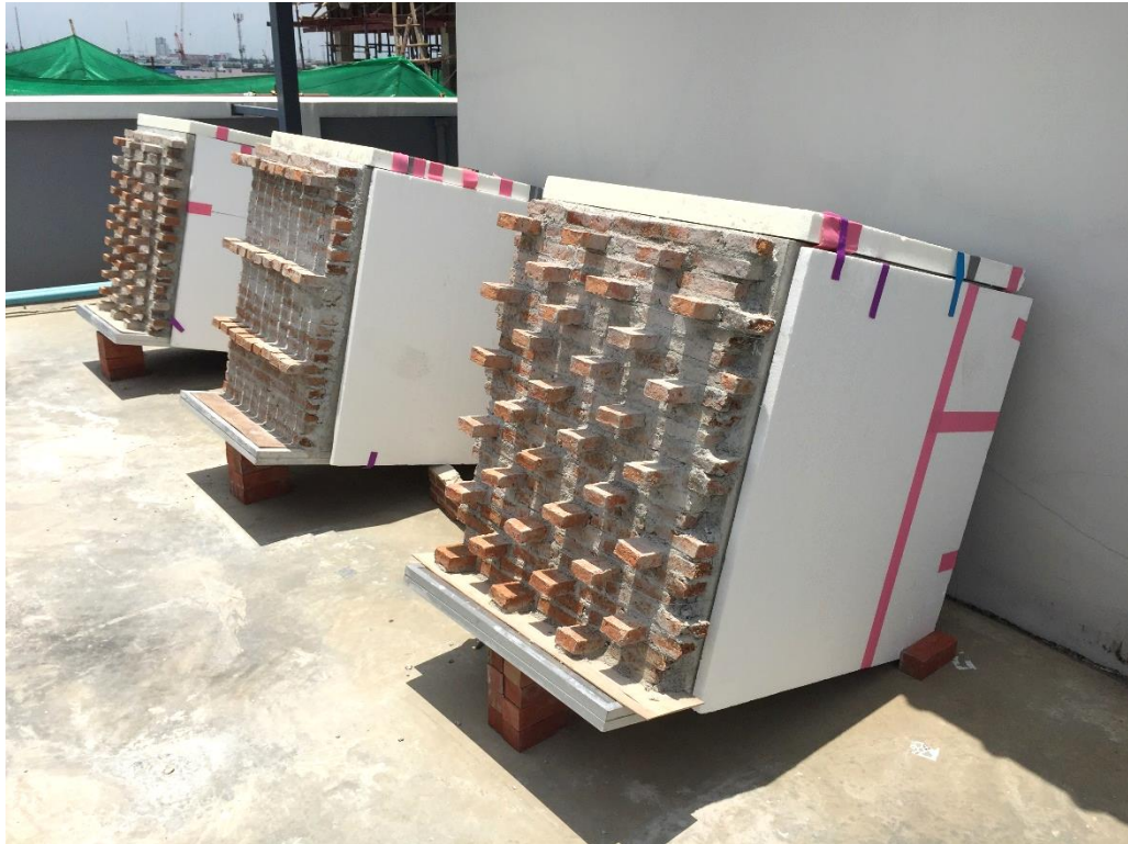
ภาพที่ 3.9 การทดลองด้วยกล่องทดลองบนดาดฟ้าอาคาร
