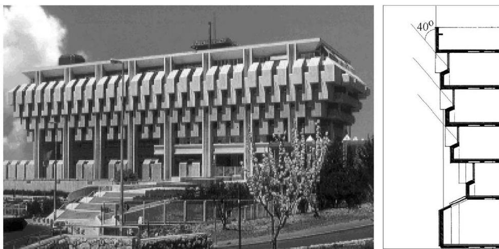
ภาพที่ 2.9 อาคารที่มีการบังแดดด้วยรูปทรงอาคาร (ที่มา : งานวิจัยของ I. Guedi Capeluto, 2013)
