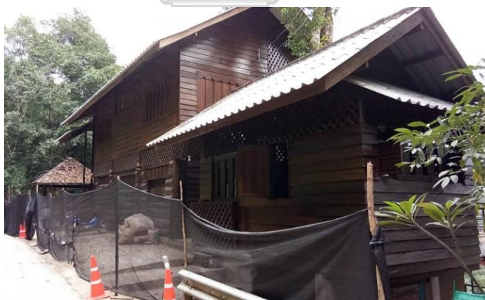
ภาพที่ 4-26: พื้นที่กำลังก่อสร้างสำหรับกิจกรรมบ้านพักรายวันและร้านกาแฟ ที่มา: ผู้วิจัย, 2561
