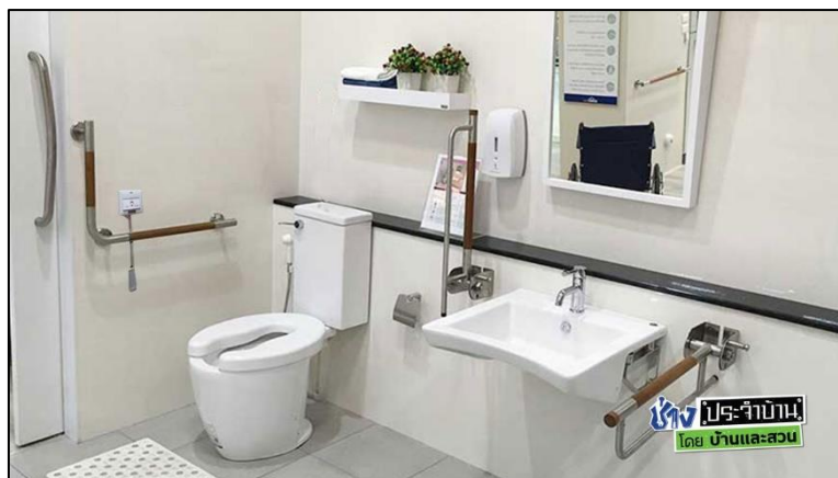
ภาพที่ 233 แสดงการติดตั้งราวจับที่เหมาะสมสำหรับผู้สูงอายุ
