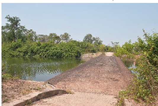
ภาพที่ 5-40 ฝายและเขื่อนกั้นการระบายน้ำ และตะกอนจากทามไปสู่น้ำ
