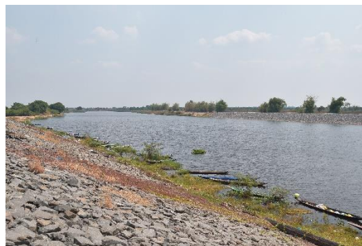
ภาพที่ 5-19 การขุดลอกแม่น้ำ โครงสร้างป้องกันตลิ่ง
