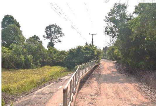
ภาพที่ 5-38 ฝายกั้นทางน้ำเชื่อมกุดกับแม่น้ำ
