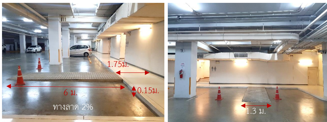
ภาพที่ 54 ทางลาดบริเวณที่จอดรถ จัดทำโดย ผู้วิจัย (21 กุมภาพันธ์ 2562)
