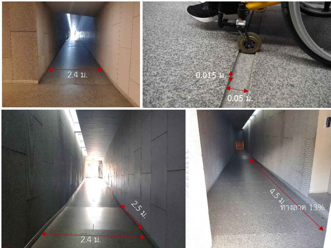
ภาพที่ 55 ทางลาดเชื่อมบริเวณที่จอดรถไปยังบริเวณนิทรรศการหรือพิพิธภัณฑ์
