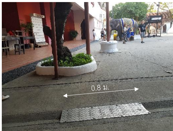
ภาพที่ 88 ทางสัญจรตะแกรงปิดร่องระบายน้ำ จัดทำโดย ผู้วิจัย (21 กุมภาพันธ์ 62)
