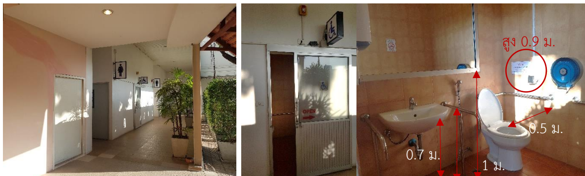
ภาพที่ 78 ห้องน้ำด้านนอกอาคาร บริเวณอาคารภัตตาหาร จัดทำโดย ผู้วิจัย (21 กุมภาพันธ์ 62)
