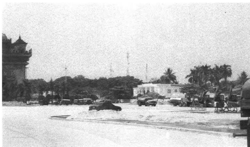
ภาพที่ 1 สภาพการก่อสร้างขยายเลนถนนล้านช้างบริเวณด้านหน้าประตูชัย
