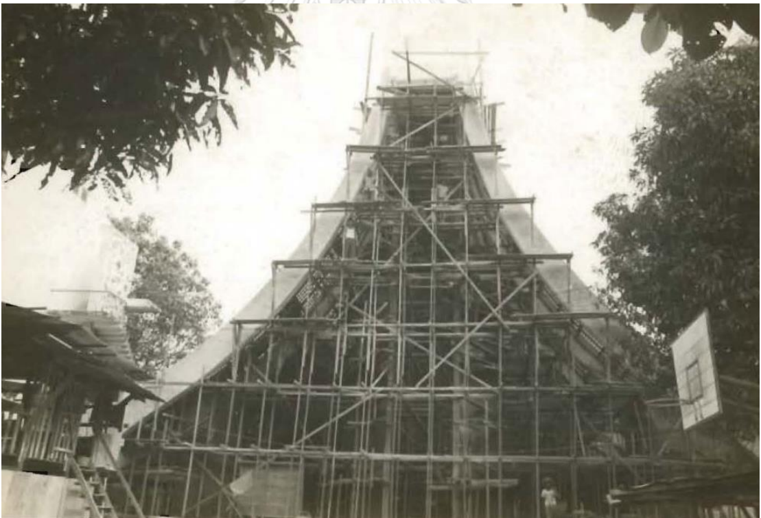
ภาพที่ 73 แสดงการก่อสร้างจันทันคอนกรีตเสริมเหล็ก (R.C. rofter) เป็นโครงสร้างหลักของอาคาร และติดตั้ง ระแนงไม้ฝังด้วยกระเบื้องหลังคาดินเผา ขนาด 1"X1" ที่มา : บราเดอร์ พันธรักษ์ เรืองสวัสดิ์, เอส.เจ., พ่อบ้านประจำวัดบ้านเซเวียร์, 17 มีนาคม 2562.
