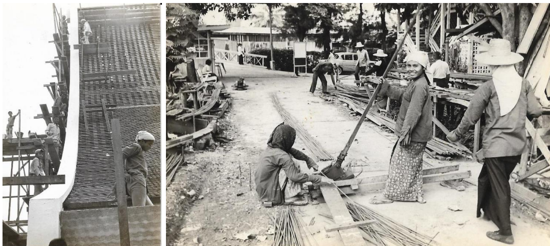
ภาพที่ 74 แสดงการติดตั้งกระเบื้องหลังคา และการตัดเหล็กเสริม สำหรับทำโครงสร้างโบสถ์บ้านเซเวียร์ โดยทีมช่างของ โกวภัทร ผู้รับเหมาหลักของโครงการ 217
