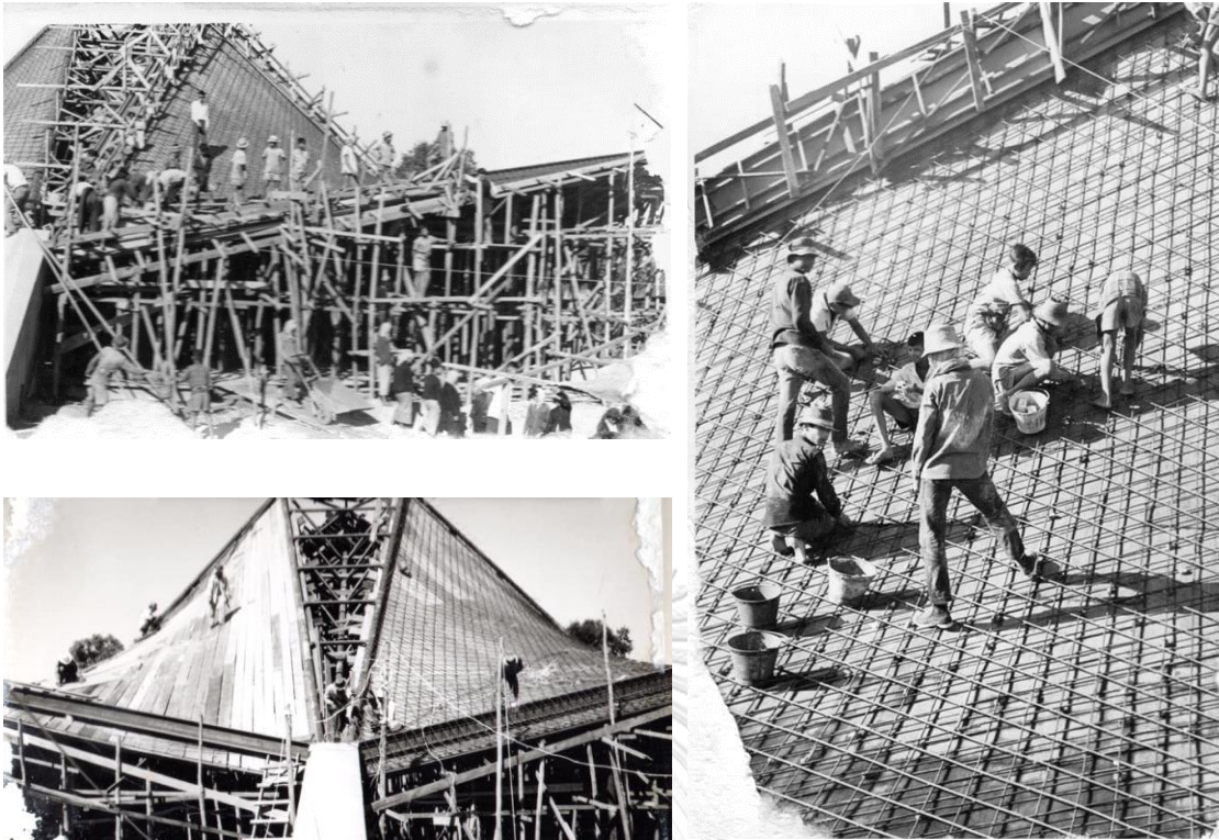
ภาพที่ 32 ภาพคนงานกำลังก่อสร้างโบสถ์แม่พระนิรมล จ.อุบลราชธานี ในปี ค.ศ.1965
