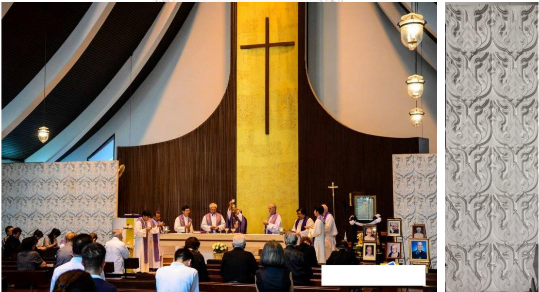
ภาพที่ 93 แสดงแผงบังตาคอนกรีตเสริมเหล็กภายในโบสถ์วัดบ้านเซเวียร์ ที่มา : สุภาวรรณ ปันติ, 2562
