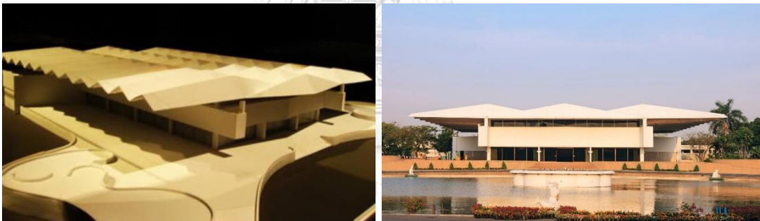
ภาพที่ 25 อาคารใหม่สวนอัมพร ใช้โครงหลังคาเป็นโครงพับจีบ (Folded Plates) ที่มา : Facebook Rerkdee Potiwanakul, 9 January 2019.
