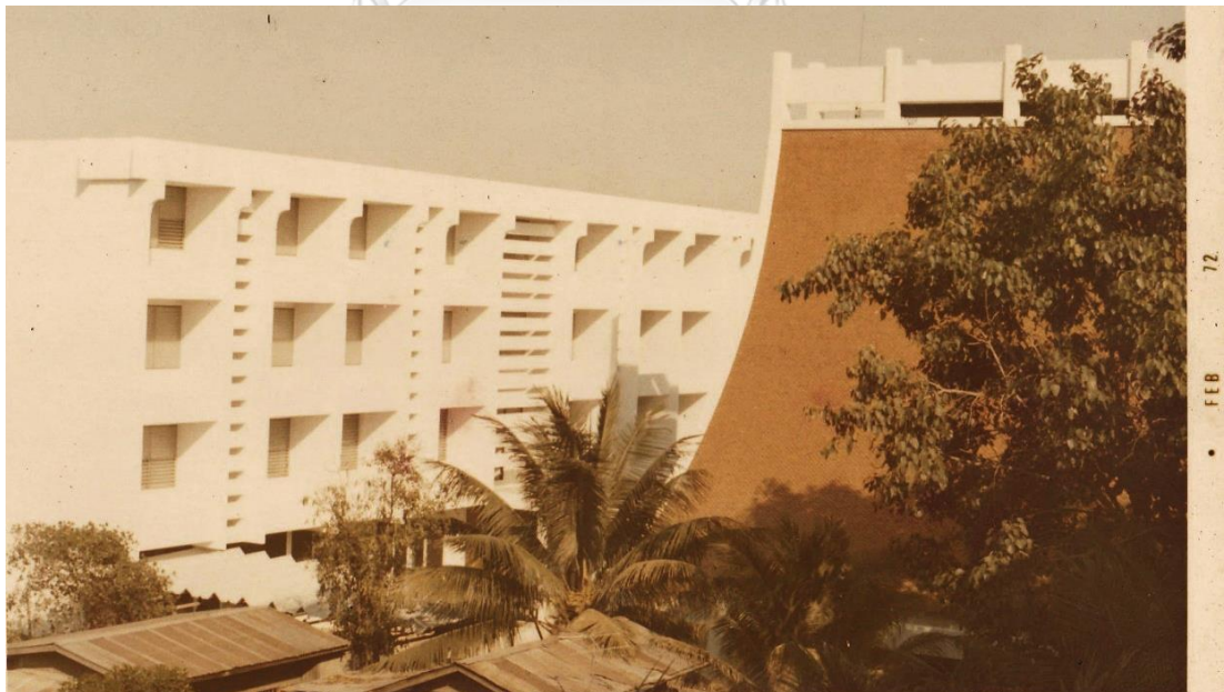
ภาพที่ 48 การก่อสร้างบ้านพักพระสงฆ์ บ้านเซเวียร์ ถ่ายภาพเมื่อปี ค.ศ.1972
