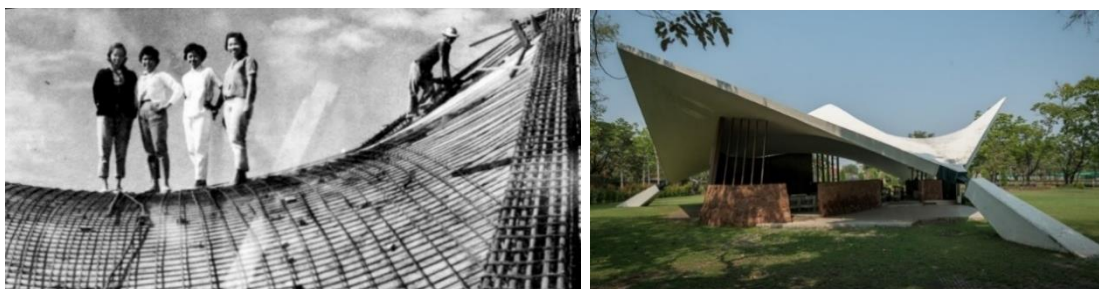
ภาพที่ 27 ภาพระหว่างการก่อสร้างอาคารครุสั้มาคาร โดยมีนักศึกษามีส่วนร่วมในการก่อสร้าง 149
