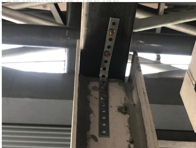
รูปที่ 3-14 แผ่นผนังถูกยึดด้วยเหล็กฉากเจาะรูยิงด้วยสกรูยึดด้านบนและล่าง
