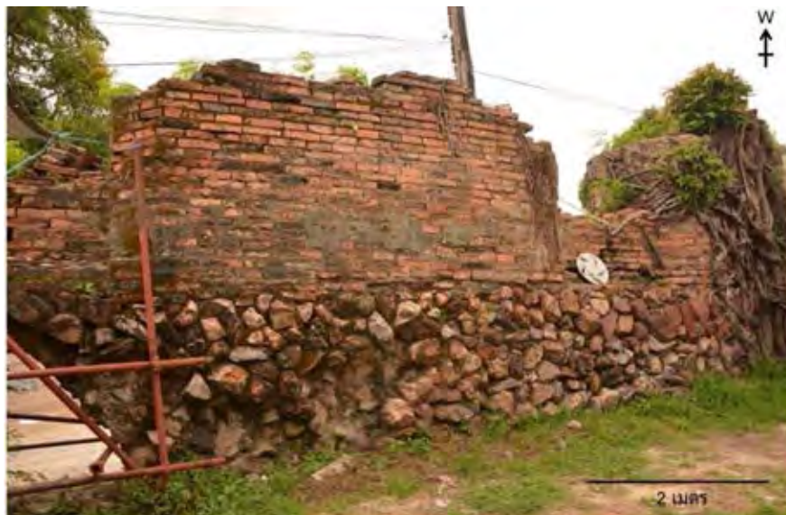
รูปที่ 4 รูปแสดงลักษณะที่ต่างกันของวัสดุที่ใช้ในการก่อกำแพงเมืองระหว่างส่วนฐานของกำแพงเมืองและส่วนบนของกำแพงเมือง ถ่ายโดยนายสารัท ชลอสันติสกุล นักโบราณคดีชำนาญการ สำนักศิลปากรที่ 11 สงขลา กรมศิลปากร
