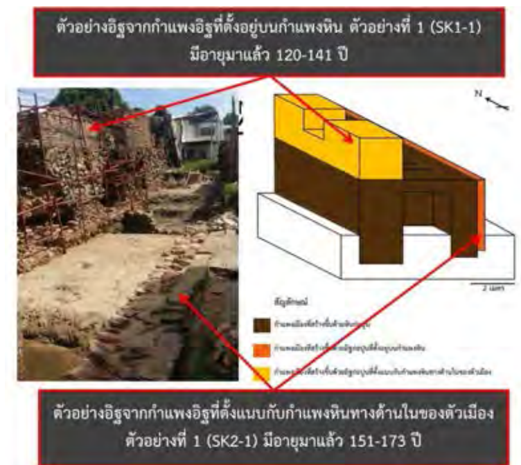
รูปที่ 26 รูปแสดงตำแหน่งและผลอายุของตัวอย่างอิฐที่ใช้ในการทดลอง
