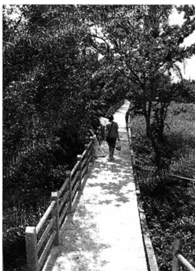
ภาพที่ 5 : ทางเดินคอนกรีตเสริมเหล็กภายในชุมชน
