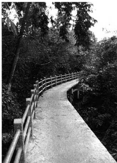
ภาพที่ 6 : ทางเดินคอนกรีตเสริมเหล็กภายในชุมชน
