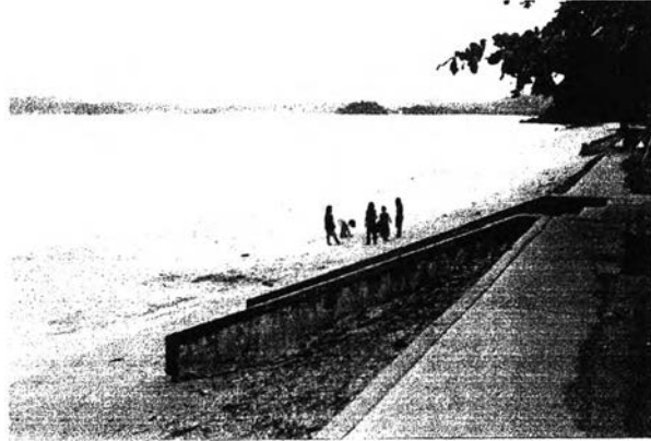
รูปที่ 5.36 แสดงการถมพื้นที่หน้าหาดสร้างเขื่อนและพลาซ่า ที่มา : จากการสำรวจภาคสนาม
