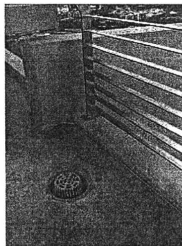
ภาพที่ 3.51 แสดงฝาท่อระบายน้ำในชั้นดาดฟ้า
