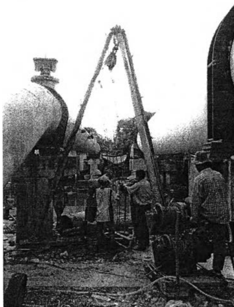
รูปที่ 3.22 แสดงการทำเข็มเจาะเสริมฐานราก
