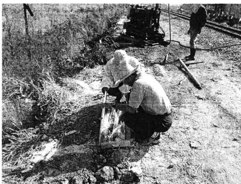
รูปที่ 3.15 ตัวอย่างที่เจาะเก็บขึ้นมาเพื่อเตรียมส่งไปทดสอบในห้องปฏิบัติการ
