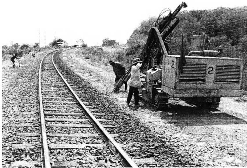
รูปที่ 3.11 ขณะทำ Jet Grouting เพื่อทำแผงที่บ้น้ำบริเวณผิวหน้าคั่นทาง
