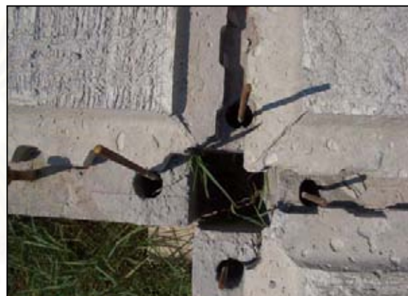
รูปที่ 5.150 แสดงการใส่เหล็กเสริมในคาน สอดทะลุมายังตอม่อ
