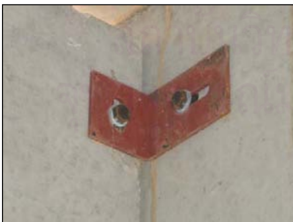
รูปที่ 5.139 แสดงการยึดผนังด้วยแผ่นเหล็ก รูปที่ 5.140 แสดงรอยต่อระหว่างผนัง
