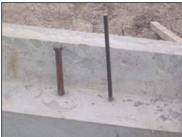
รูปที่ 5.135 แสดงการปรับระดับ Erection Bolt รูปที่ 5.136 แสดงการยกติดตั้งผนังสำเร็จรูปชั้นล่าง ที่มา : จากการสำรวจ ณ สถานที่ก่อสร้างโครงการภัสสร 12 รั้งสิตคลอง 3
