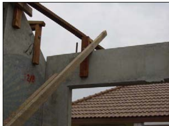
รูปที่ 5.100 แสดงการยึดผนังกับพื้น ชั้นสำเร็จรูป
