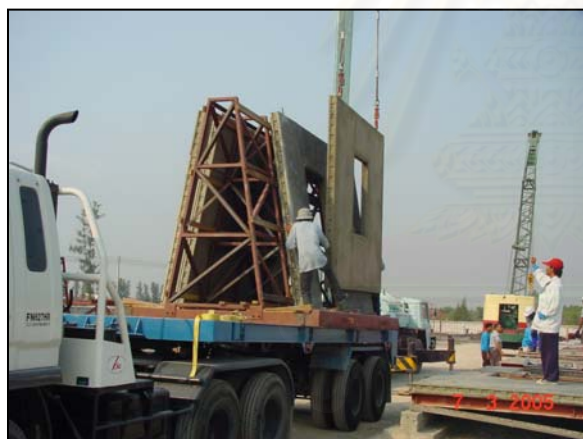
รูปที่ 5.123 แสดงขั้นตอนการขนส่ง
