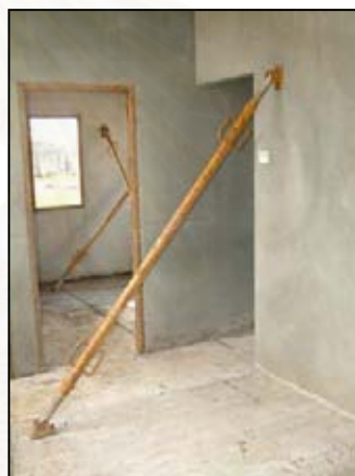
รูปที่ 5.137 แสดงการวางชิ้นงาน ให้ตรงกับเหล็กเสริม รูปที่ 5.138 แสดงเสาค้ำยันยึดผนังกับพื้น
