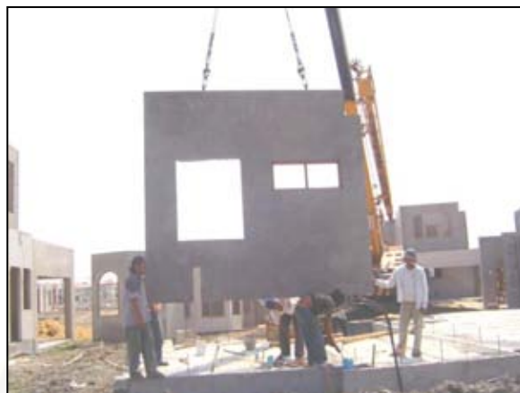
รูปที่ 5.135 แสดงการปรับระดับ Erection Bolt รูปที่ 5.136 แสดงการยกติดตั้งผนังสำเร็จรูปชั้นล่าง ที่มา : จากการสำรวจ ณ สถานที่ก่อสร้างโครงการภัสสร 12 รั้งสิตคลอง 3
