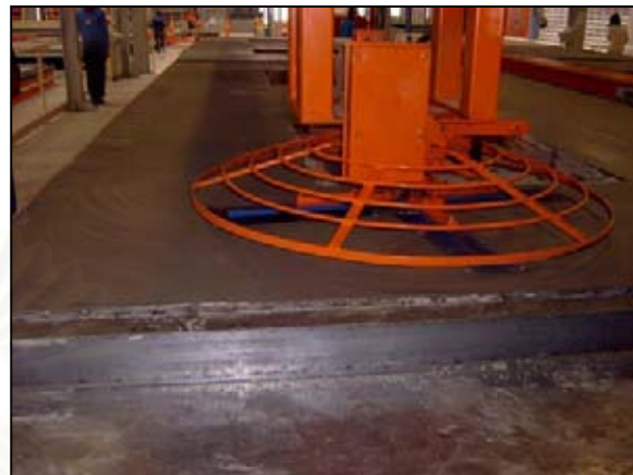
รูปที่ 5.25 แสดงรายละเอียดเครื่อง Smoothing
