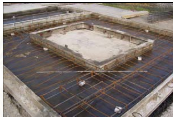
รูปที่ 5.108 แสดงขั้นตอนการเตรียมเหล็กตะแกรง รูปที่ 5.109 แสดงการวางวางเหล็กตะแกรง ที่มา : จากการสำรวจ ณ โรงงานชั่วคราวผลิตชิ้นส่วนสำเร็จรูป บริษัท ซีอตรงกรุ๊ป จำกัด รังสิตคลอง 3
