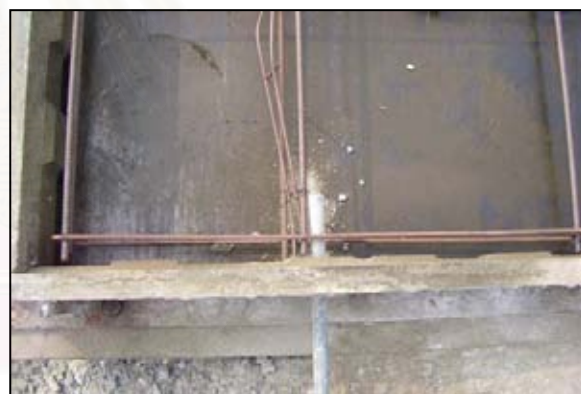
รูปที่ 5.110 แสดงการติดตั้ง J-BOLT รูปที่ 5.111 แสดงการติดตั้งรูสำหรับเสียบ J-BOLT ที่มา : จากการสำรวจ ณ โรงงานชั่วคราวผลิตชิ้นส่วนสำเร็จรูป บริษัท ซีอตรงกรุ๊ป จำกัด รังสิตคลอง 3
