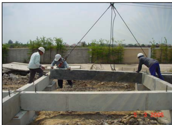
รูปที่ 5.149 แสดงงานวางคานสำเร็จรูป
