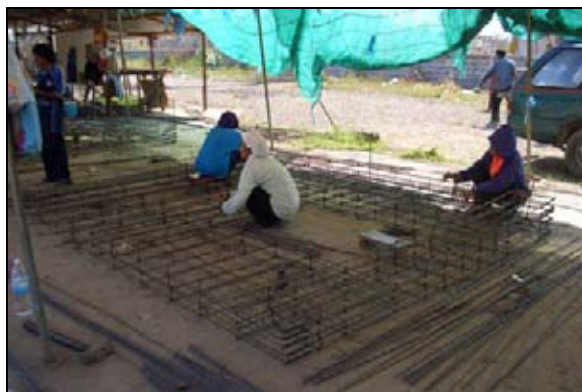
รูปที่ 5.108 แสดงขั้นตอนการเตรียมเหล็กตะแกรง รูปที่ 5.109 แสดงการวางวางเหล็กตะแกรง ที่มา : จากการสำรวจ ณ โรงงานชั่วคราวผลิตชิ้นส่วนสำเร็จรูป บริษัท ซีอตรงกรุ๊ป จำกัด รังสิตคลอง 3
