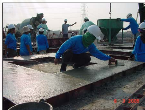
รูปที่ 5.114 แสดงขั้นตอนการขัดผิวหน้า รูปที่ 5.115 แสดงการใช้แรงงานคนตกแต่งผิว ที่มา : จากการสำรวจ ณ โรงงานชั่วคราวผลิตชิ้นส่วนสำเร็จรูป บริษัท ซีอตรงกรุ๊ป จำกัด รังสิตคลอง 3
