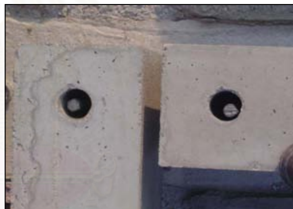
รูปที่ 5.128 แสดงการใส่เหล็กเสริมในคานกับตอม่อ
