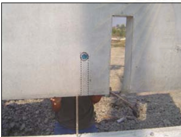
รูปที่ 5.137 แสดงการวางชิ้นงาน ให้ตรงกับเหล็กเสริม รูปที่ 5.138 แสดงเสาค้ำยันยึดผนังกับพื้น
