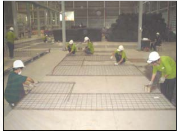
รูปที่ 5.46 แสดงการเตรียมตะแกรงเหล็ก
