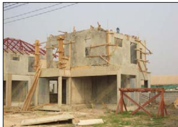
รูปที่ 5.162 แสดงการติดตั้งชั้นส่วนแล้วเสร็จ
