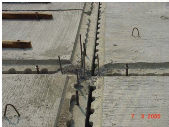
รูปที่ 5.151 แสดงงานวางพื้นสำเร็จรูปชั้นล่าง รูปที่ 5.152 แสดงการเตรียมงานสำหรับติดตั้งผนัง ที่มา : จากการสำรวจ ณ สถานที่ก่อสร้างโครงการซื้อตรง รัชสิดคลอง 3
