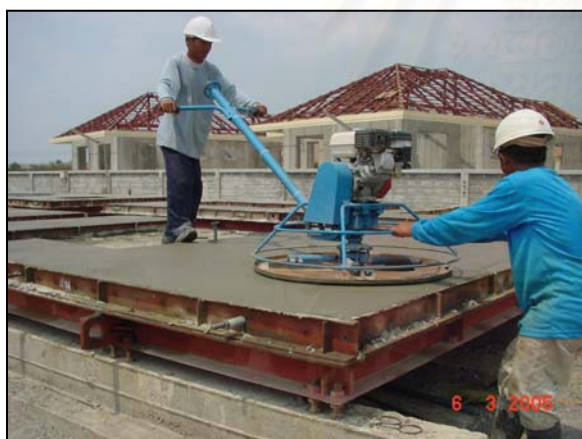
รูปที่ 5.114 แสดงขั้นตอนการขัดผิวหน้า รูปที่ 5.115 แสดงการใช้แรงงานคนตกแต่งผิว ที่มา : จากการสำรวจ ณ โรงงานชั่วคราวผลิตชิ้นส่วนสำเร็จรูป บริษัท ซีอตรงกรุ๊ป จำกัด รังสิตคลอง 3
