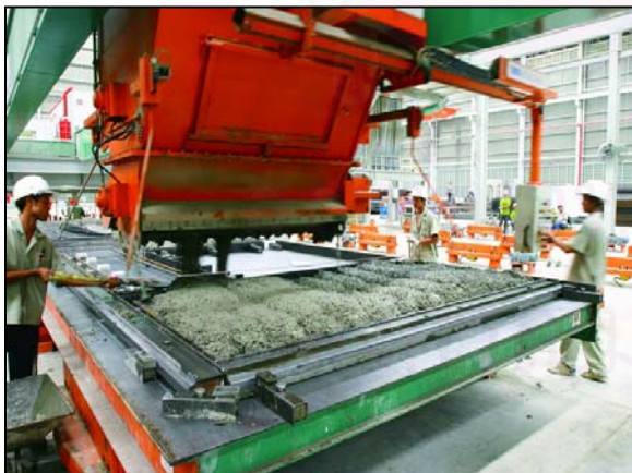
รูปที่ 5.18 แสดงส่วน Concrete Placing
