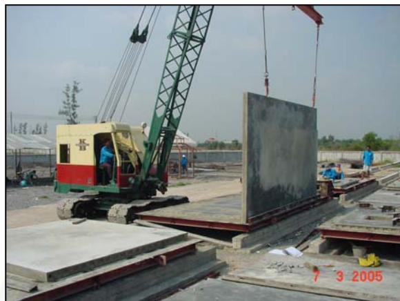
รูปที่ 5.116 แสดงขั้นตอนถอดแบบข้าง รูปที่ 5.117 แสดงการยกชิ้นงาน ที่มา : จากการสำรวจ ณ โรงงานชั่วคราวผลิตชิ้นส่วนสำเร็จรูป บริษัท ซีอตรงกรุ๊ป จำกัด รังสิตคลอง 3
