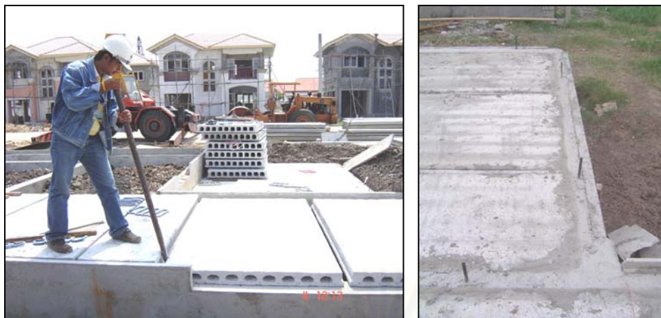
รูปที่ 5.133 แสดงงานวางพื้นสำเร็จรูปชั้นล่าง รูปที่ 5.134 แสดงเทคนิคการยึดเพื่อยึดพื้นกับคาน ที่มา : จากการสำรวจ ณ สถานที่ก่อสร้างโครงการภัสสร 12 ริงสิตคลอง 3
