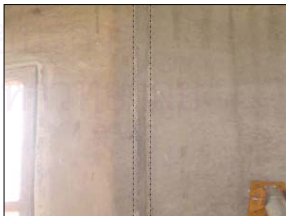
รูปที่ 5.139 แสดงการยึดผนังด้วยแผ่นเหล็ก รูปที่ 5.140 แสดงรอยต่อระหว่างผนัง
