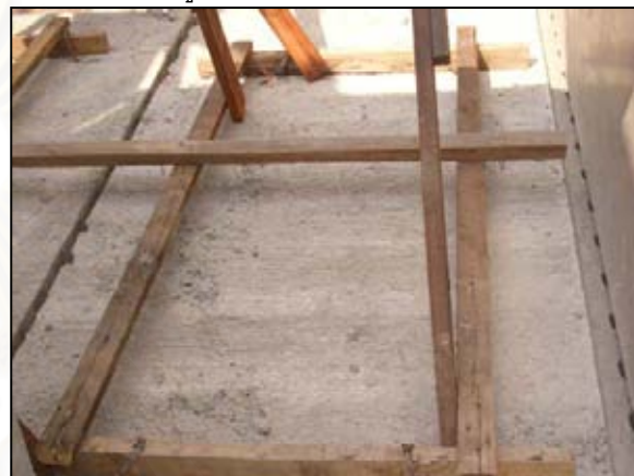
รูปที่ 5.151 แสดงงานวางพื้นสำเร็จรูปชั้นล่าง รูปที่ 5.152 แสดงการเตรียมงานสำหรับติดตั้งผนัง ที่มา : จากการสำรวจ ณ สถานที่ก่อสร้างโครงการซื้อตรง รัชสิดคลอง 3
