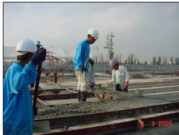
รูปที่ 5.112 แสดงขั้นตอนการเทคอนกรีต รูปที่ 5.113 แสดงการใช้เครื่องจี้คอนกรีต ที่มา : จากการสำรวจ ณ โรงงานชั่วคราวผลิตชิ้นส่วนสำเร็จรูป บริษัท ซีอตรงกรุ๊ป จำกัด รังสิตคลอง 3
