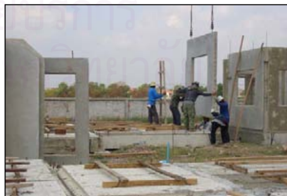
รูปที่ 5.155 แสดงการยกติดตั้งผนังสำเร็จรูปชั้นล่าง
