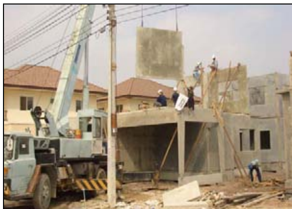
รูปที่ 5.161 แสดงการยกติดตั้งผนังสำเร็จรูปชั้นบน
