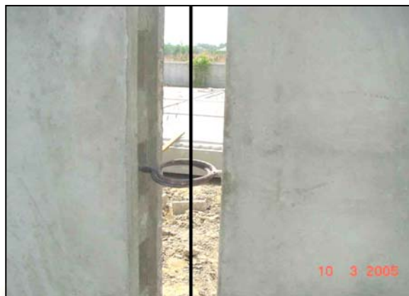
รูปที่ 5.157 แสดงใส่เหล็กเสริมในช่องระหว่าง
