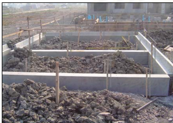
รูปที่ 5.127 แสดงการวางคานสำเร็จรูป
