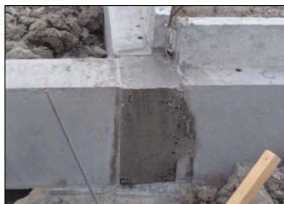
รูปที่ 5.130 แสดงการเทคอนกรีตยึดคาน
