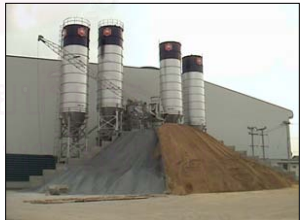
รูปที่ 5.19 แสดงเครื่องผสมคอนกรีต
