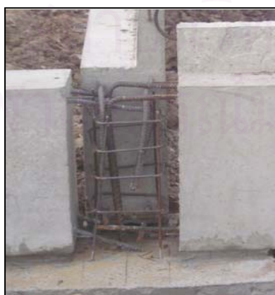
รูปที่ 5.129 แสดงการใส่เหล็กเสริมระหว่างหัวคาน
