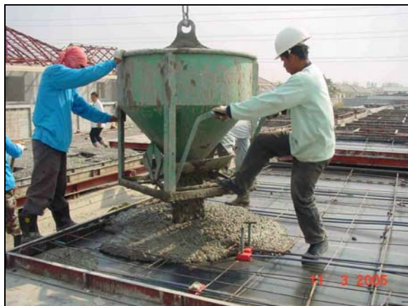
รูปที่ 5.112 แสดงขั้นตอนการเทคอนกรีต รูปที่ 5.113 แสดงการใช้เครื่องจี้คอนกรีต ที่มา : จากการสำรวจ ณ โรงงานชั่วคราวผลิตชิ้นส่วนสำเร็จรูป บริษัท ซีอตรงกรุ๊ป จำกัด รังสิตคลอง 3
