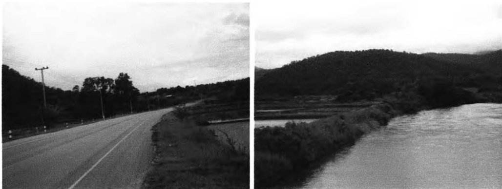
รูปที่ 6.16 การตัดถนนผ่านพื้นที่เกษตรกรรมก่อให้เกิดปัญหาเรื่องของน้ำท่วมพื้นที่เกษตรกรรม
