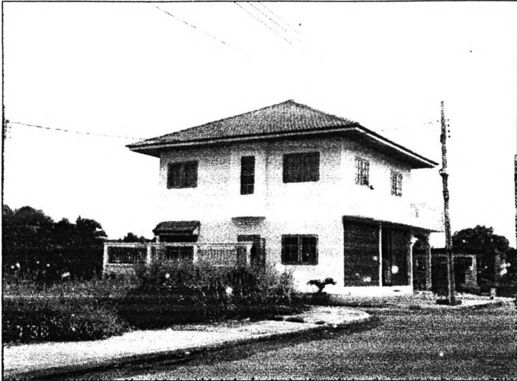
ภาพที่ 30 บ้านสองชั้นโครงสร้างคอนกรีตเสริมเหล็ก และก่ออิฐฉาบปูน
