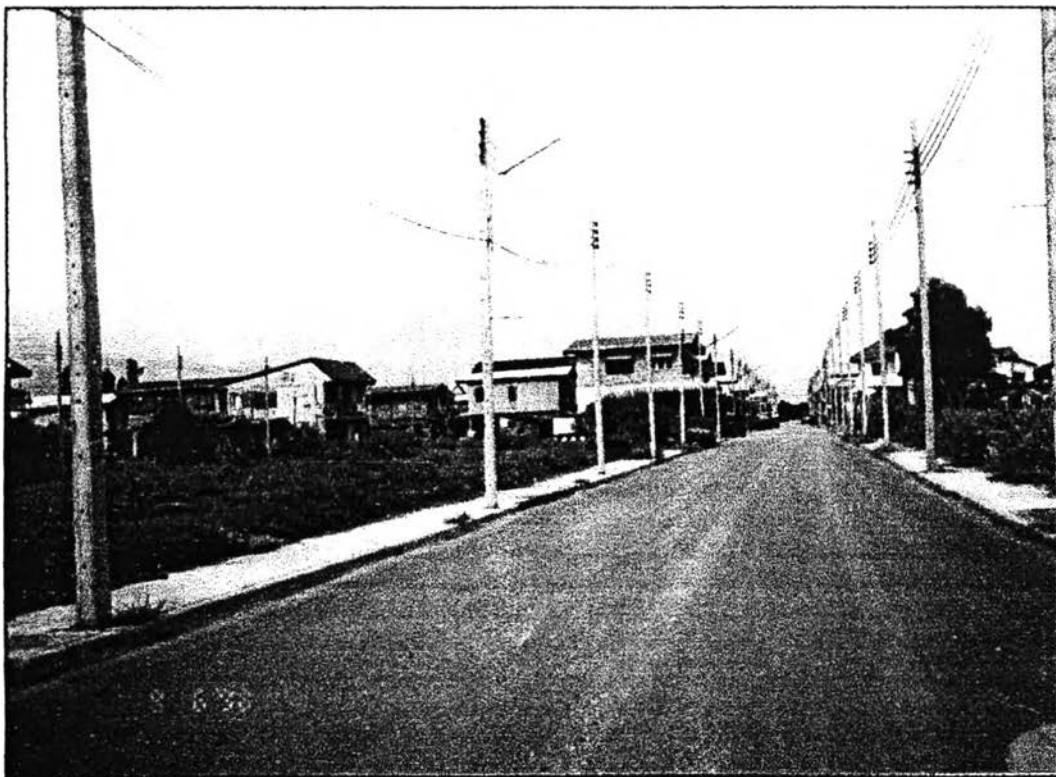
ภาพที่ 13 สภาพถนนหลักในชุมชนวัชรพล 3 ฝั่งจากรจร แอสฟัลท์ติกคอนกรีต เขตทางกว้าง 14 เมตร พร้อมทางเท้า 2 ข้าง
