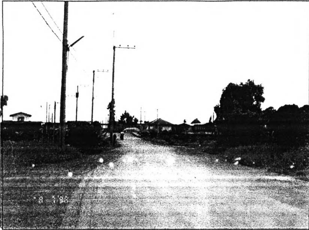
ภาพที่ 12 สภาพถนนด้านหน้าชุมชนวัชรพล 3 เป็นถนนหินเกล็ดบดอัด ช่วงระยะประมาณ 100 เมตร ก่อนเข้าโครงการ
