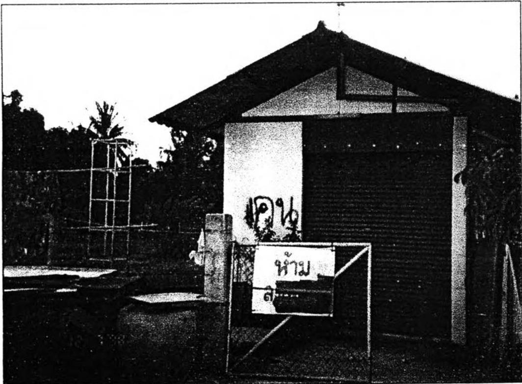
ภาพที่ 8 ห้องควบคุมการเติมออกซิเจนในน้ำเสีย และเครื่องสูบน้ำ
