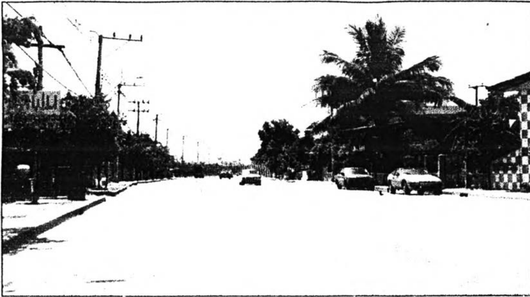
ภาพที่ 9 สภาพถนน สุขาภิบาล 5 ฝั่งทางคอนกรีตเขตทาง กว้าง 4 ช่องทาง พร้อมทางเท้าทั้ง 2 ข้าง
