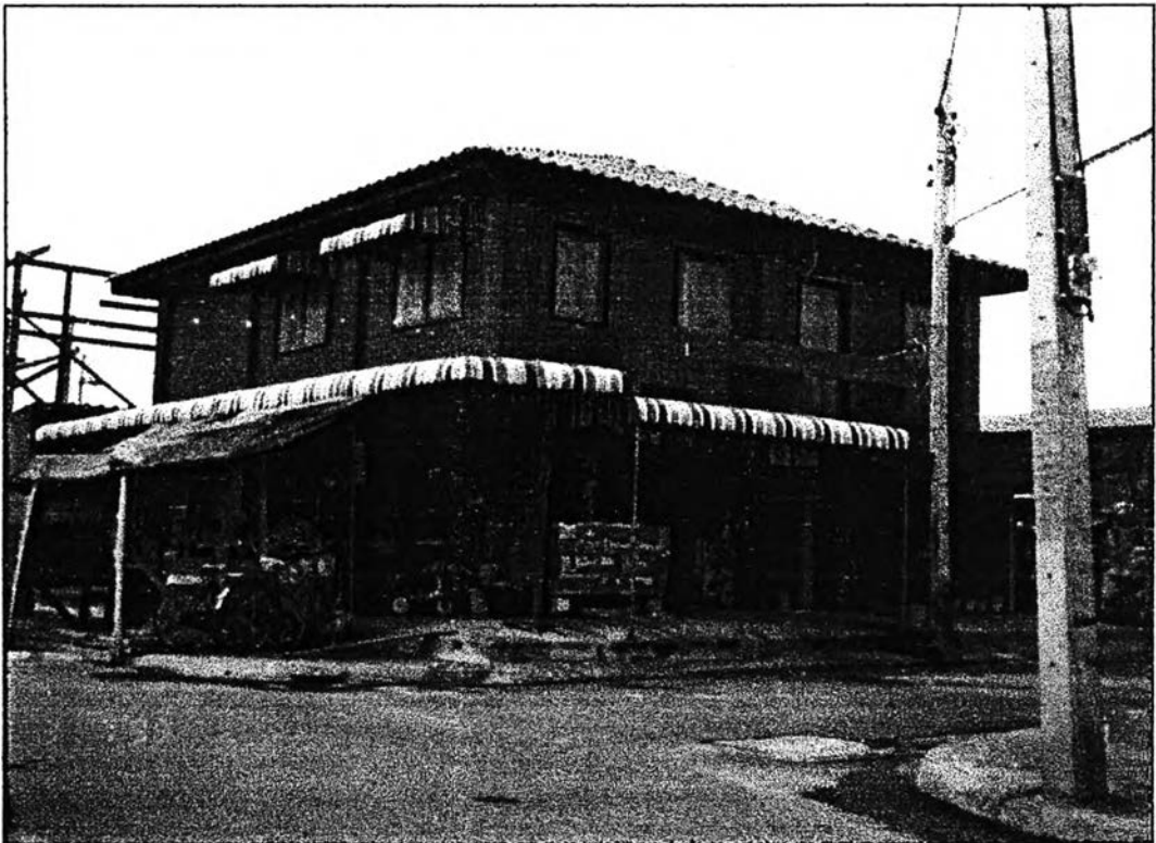
ภาพที่ 31 ลักษณะบ้านสองชั้น โครงสร้างผนังกับน้ำหนัก โดยใช้อิฐบล็อกดินซีเมนต์ โดยความร่วมมือกับสถาบันวิจัยวิทยาศาสตร์และเทคโนโลยีแห่งประเทศไทย (วท.)
