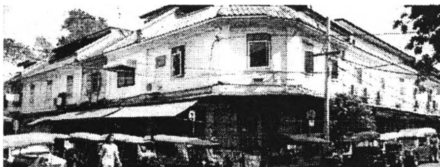
ภาพที่ 3.2 แสดงอาคารในกลุ่มที่ 2 เป็นกลุ่มอาคารเดียวกันกับภาพที่ 3.1 แต่ได้รับการซ่อมบำรุง ทาสี แต่งผิวผนัง และเปลี่ยนวัสดุต่างๆ ได้แก่ วัสดุผนังหลังคา และหน้าต่าง
