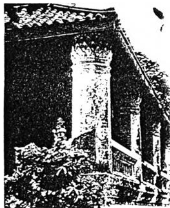
รายละเอียดบัวหัวเสาแบบบัวกลุ่ม
