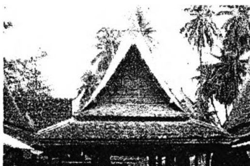
รูปที่ 2.11 บ้านลมตัวเหงาของเรือนไทยภาคกลาง (ฤทัย ใจจงรัก, 2536: 43)
