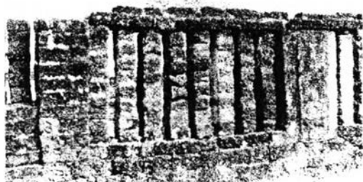
การเจาะช่องแสงเป็นเส้นตั้งตรง
