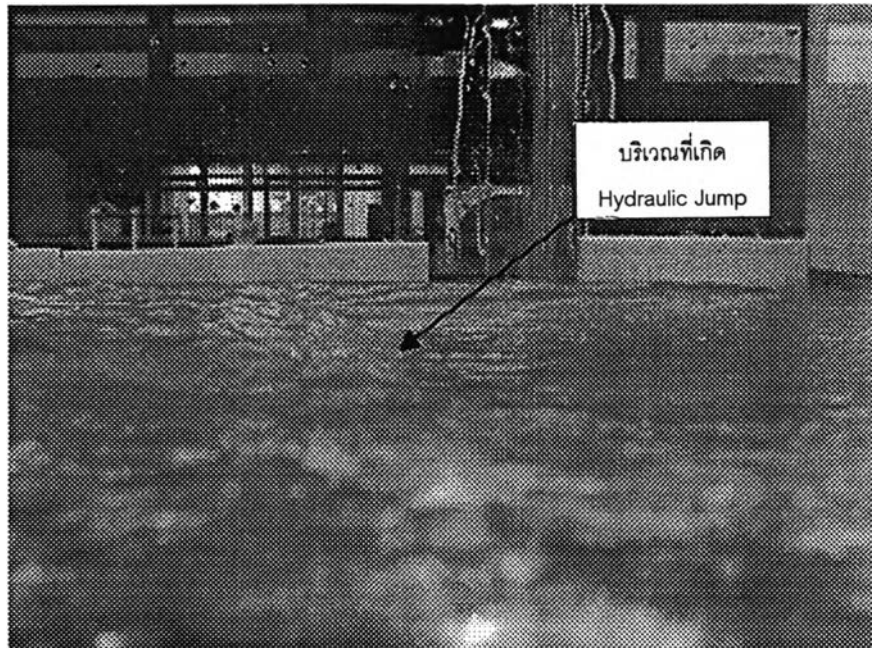
รูป ๙-21 การเกิด Hydraulic Jump บริเวณด้านท้ายน้ำของ ตะแกรงผันน้ำ
