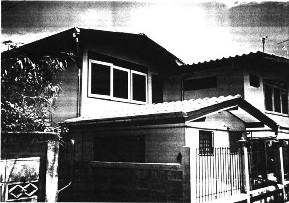
ภาพที่ 5-5 การต่อเติมด้านหลังของบ้านเป็น 2 ชั้น และชั้นเดียวของบ้านระบบ เสา – คาน
