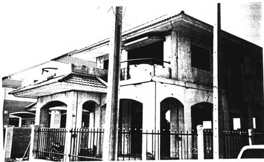
ภาพที่ 5 - 1 ระบบการก่อสร้างกึ่งสำเร็จรูป ประเภทผนังรับน้ำหนัก
