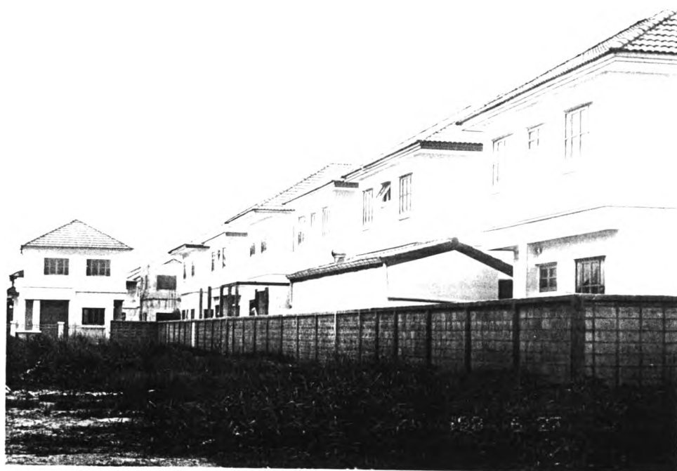
ภาพที่ 5-4 การต่อเติมด้านหลัง ของบ้านระบบผนังรับน้ำหนัก
