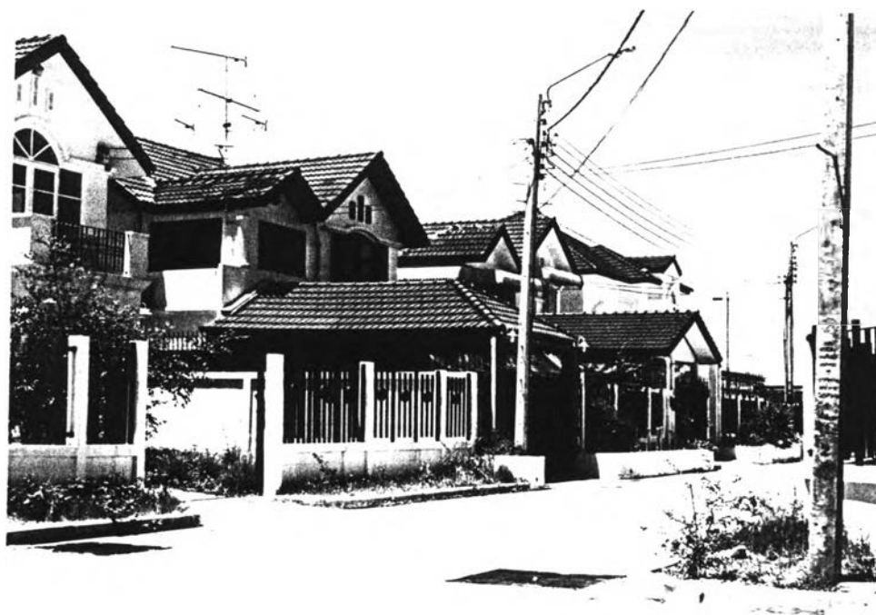
ภาพที่ 5-3 การต่อเติม ด้านหน้าบ้านเป็นที่จอดรถ และต่อเติมชั้นบนซึ่งเดิมเป็นระเบียง
