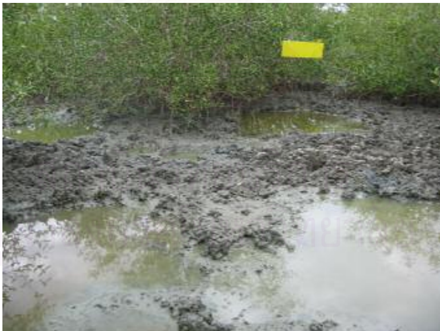
รูปที่ ง-4 แสดงลักษณะการเชื่อมต่อกันของหลุมฝังกลบขยะที่อยู่ติดกันหลังจากการฝังกลบ 7 เดือน
