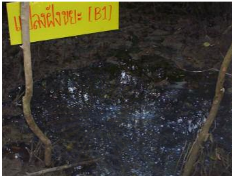
รูปที่ ง-1 แสดงลักษณะหลุมที่มีน้ำท่วมขังภายหลังการฝายกลบขยะ
