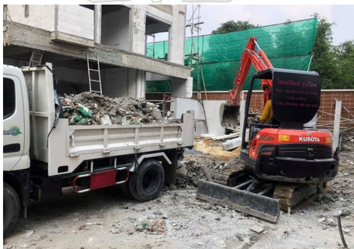
รูปที่ 1.3 รถแบคโฮตักของเสียที่กองอยู่ในพื้นที่ก่อสร้างใส่รถบรรทุก
