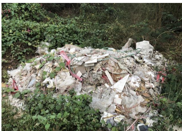
รูปที่ 1.4 กองของเสียจากการก่อสร้างตามที่รกร้าง
