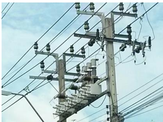
รูปที่ 2-4 คาปาซิเตอร์แบบคงที่
