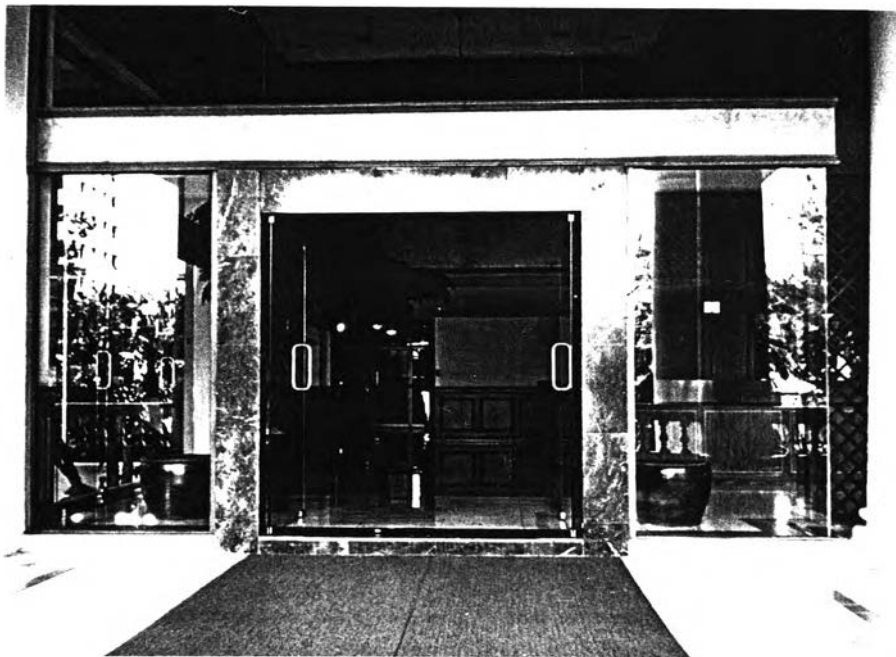
ภาพที่ 44 แสดงภาพถ่ายประตูหน้าต่างโครงการDS.Tower
