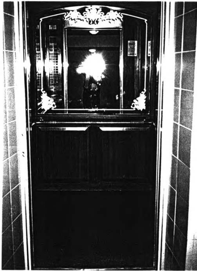
ภาพที่ 43 แสดงภาพถ่ายระบบลิฟท์(ภายใน)โครงการ DS.Tower
