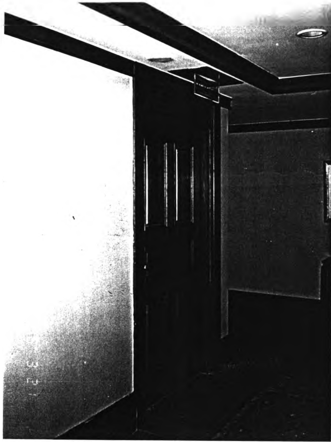
ภาพที่ 30 แสดงภาพถ่าย ระบบป้องกันเพลิงไหม้ (บันไดหนีไฟ) โครงการ สมคิดการเดิน
