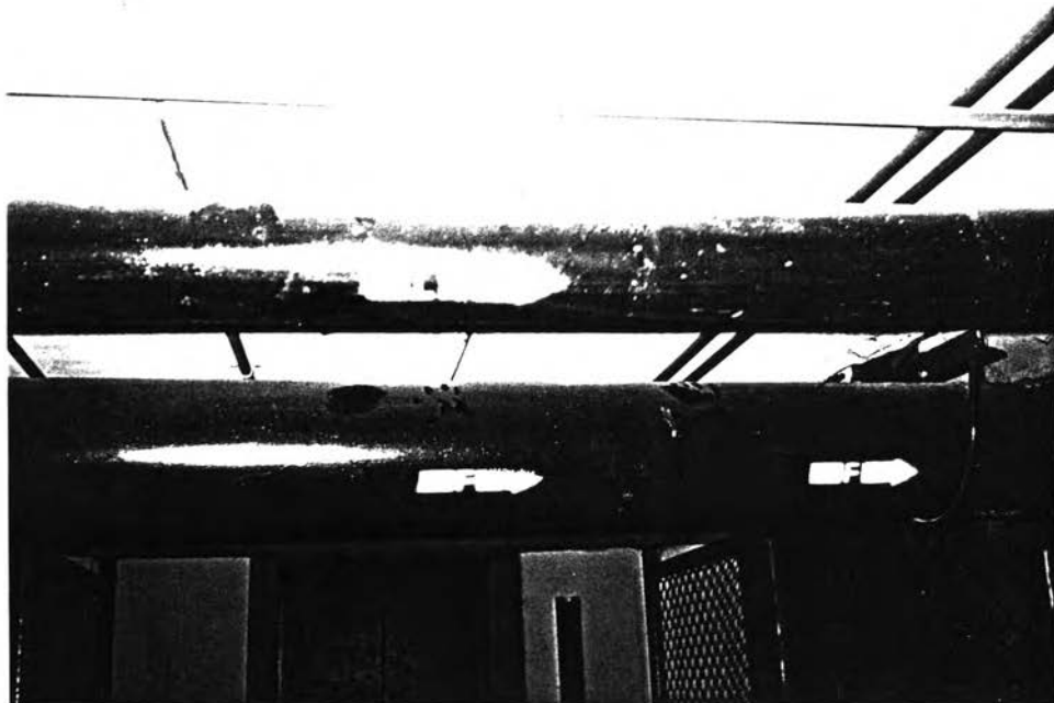
ภาพที่ 136 แสดงภาพถ่าย ระบบประปาสาขาภิบาล โครงการ President Park
