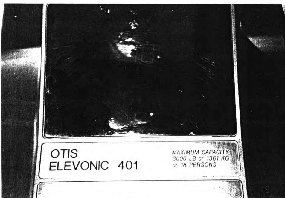
ภาพที่ 160 แสดงภาพถ่ายระบบลิฟท์หน้าหนักบรรทุกโครงการสาธาปาร์คเพลส
