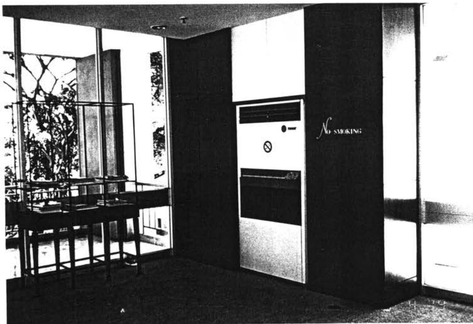
ภาพที่ 172 แสดงภาพถ่ายระบบปรับอากาศโครงการ สาธารณูปโภค
