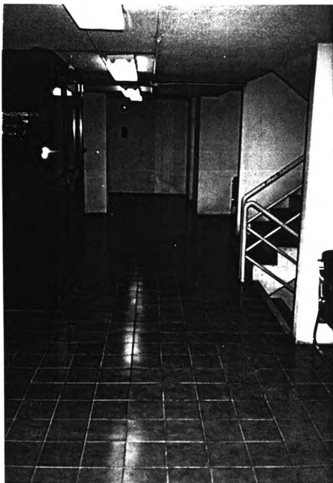
ภาพที่ 65 แสดงภาพถ่ายผนังและวัสดุปูผนังโครงการ Century Height
