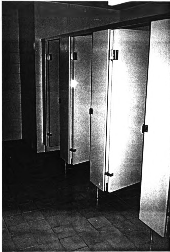
ภาพที่ 47 แสดงภาพถ่าย ห้องนำส่วนกลาง โครงการ DS.Tower
