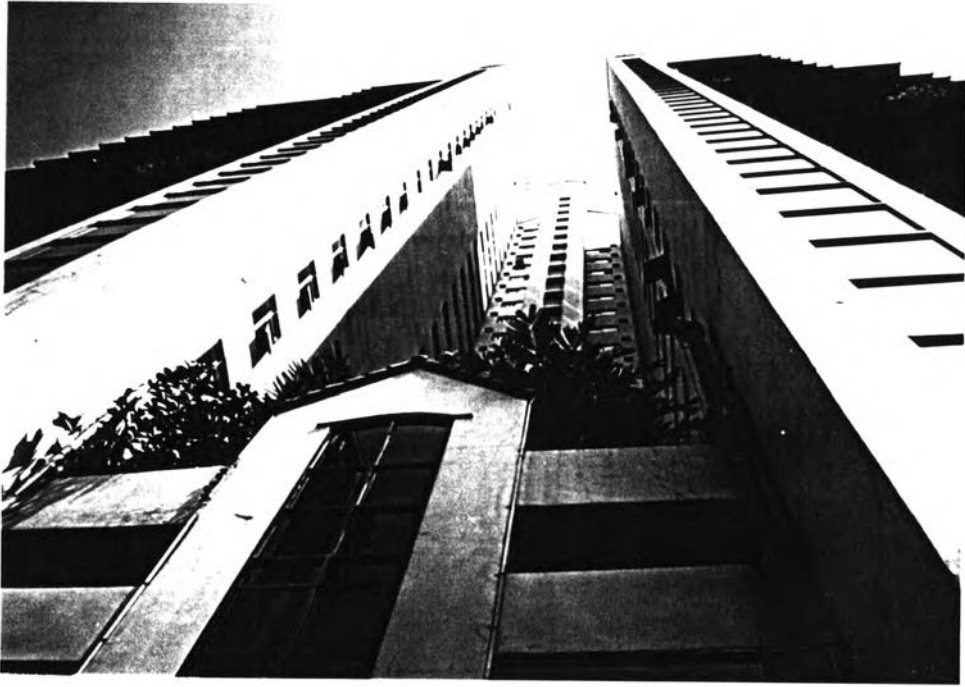
ภาพที่ 63 แสดงภาพถ่ายผนังภายนอก โครงการ Century Height
