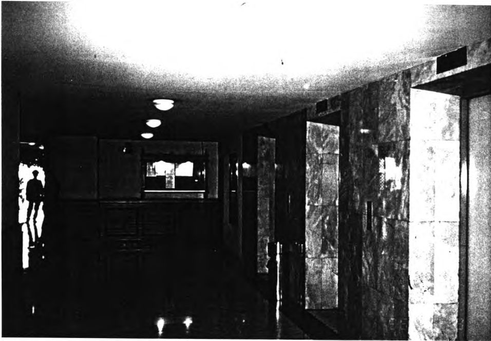
ภาพที่ 41 แสดงภาพถ่ายผนังและวัสดุบุผนังโครงการ DS.Tower
