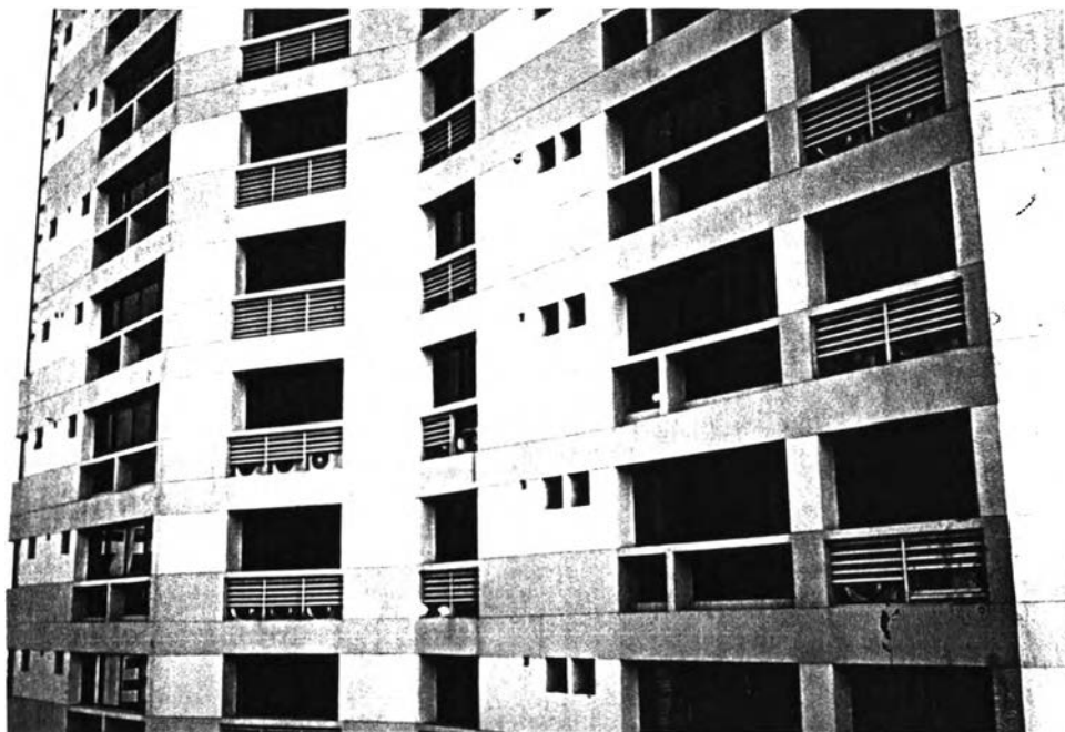
ภาพที่ 122 แสดงภาพถ่ายผนังภายนอกอาคารโครงการ President Park
