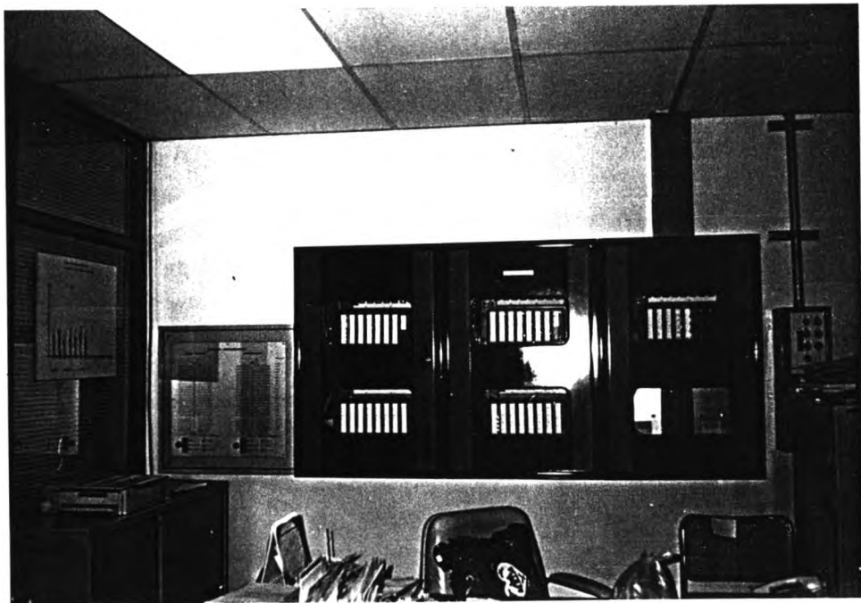
ภาพที่ 110 แสดงภาพถ่ายระบบป้องกันเพลิง(ตู้รับสัญญาณ)โครงการ Richmond Palace
