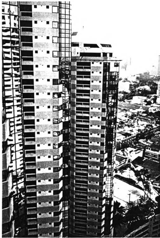
ภาพที่ 121 แสดงภาพถ่ายผนังภายนอกอาคารโครงการ President Park
