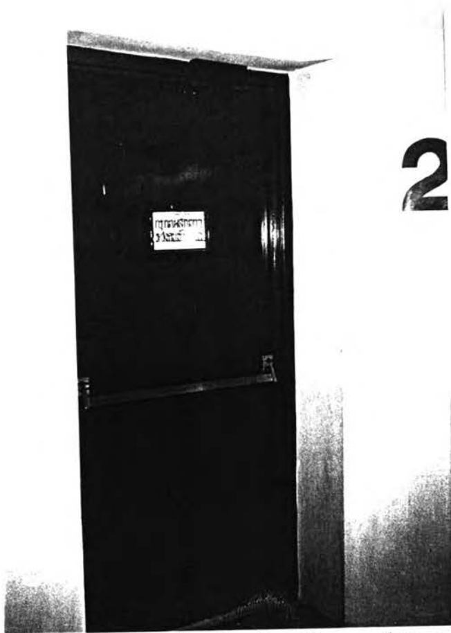
ภาพที่ 175 แสดงภาพถ่าย ระบบป้องกันเพลิงไหม้(ประตุน้ำไฟ) โครงการ สาธารณูปโภคพิเศษ
