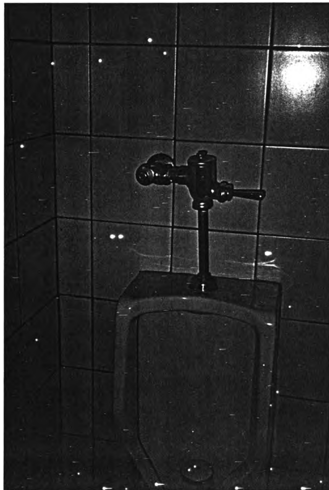
ภาพที่ 240 โถปัสสาวะแบบติดผนังท่อและข้อต่อเปลี่ยนสามารถรื้อและประกอบได้โดยไม่ต้องทุบผนัง
