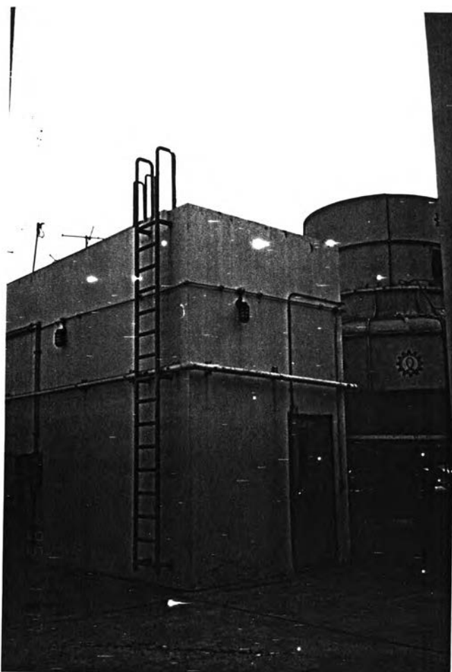
ภาพที่ 197 มีบันไดติดตั้งไว้อย่างถาวรสำหรับขึ้นไปตรวจสอบสภาพหลังคาได้
