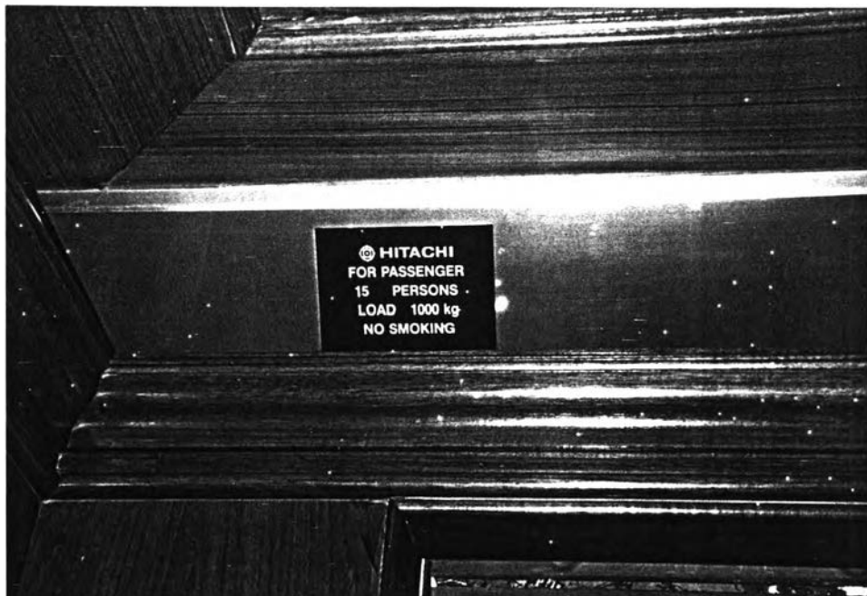
ภาพที่ 220 ลิฟต์โดยสารและลิฟต์ดับเพลิงมีขนาดมวลบรรทุกไม่น้อยกว่า 630 กิโลกรัม
