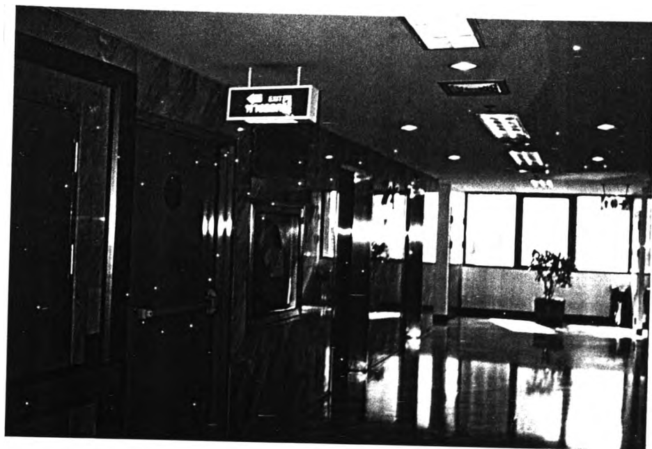
ภาพที่ 222 - บริเวณห้องโถงหน้าลิฟต์ดับเพลิงทุกชั้นต้องติดตั้งตู้สายฉีดดับเพลิงและอุปกรณ์ดับเพลิงอื่นๆ
