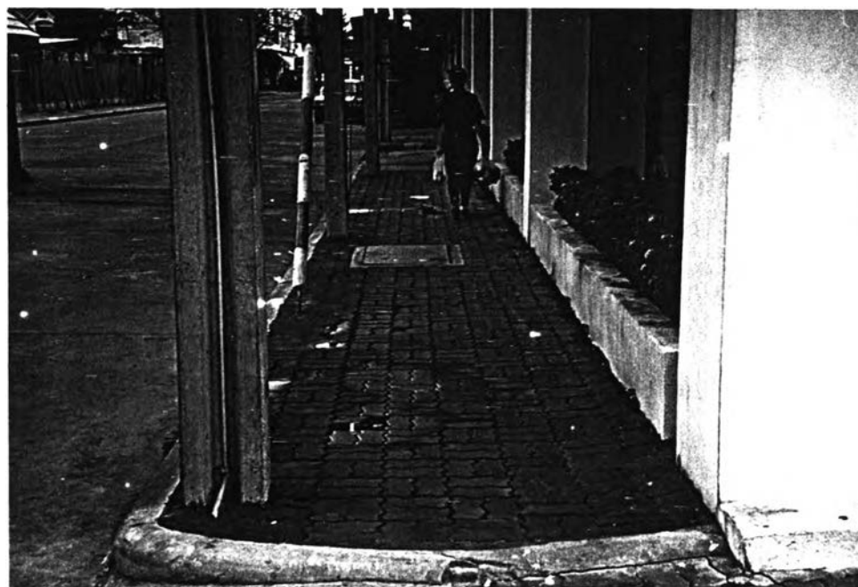
ภาพที่ 187 พื้นทางเดินมีความลาดเอียงลงทั้งสองข้างเพื่อป้องกันน้ำขังนองบนผิวพื้น
