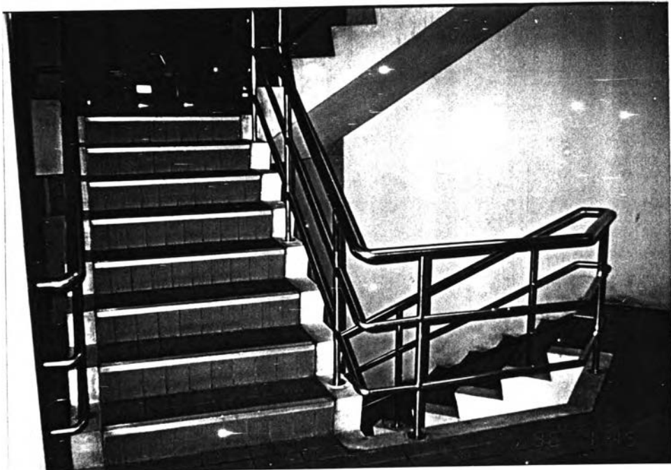
ภาพที่ 211 พื้นชั้นบันไดเป็นหินขัดหรือกระเบื้องเซรามิค ราวและลูกกรงราวบันไดเป็นสแตนเลสตีลสายตรง ไม่มีลวดลายโค้งงอ
