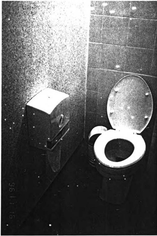
ภาพที่ 239 ที่ใส่กระดาษชำระ มีฝาครอบปิดล็อกได้ เพื่อป้องกันการใช้กระดาษอย่างสิ้นเปลือง
