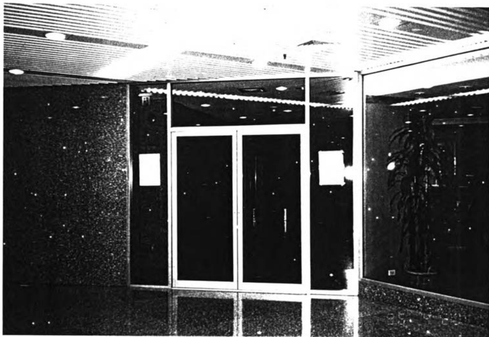
ภาพที่ 228 บานประตูเป็น เหล็ก หรือ กระจก กรอบเป็นเหล็ก หรือ อลูมิเนียม วงกบประตูเป็นเหล็กหรืออลูมิเนียม
