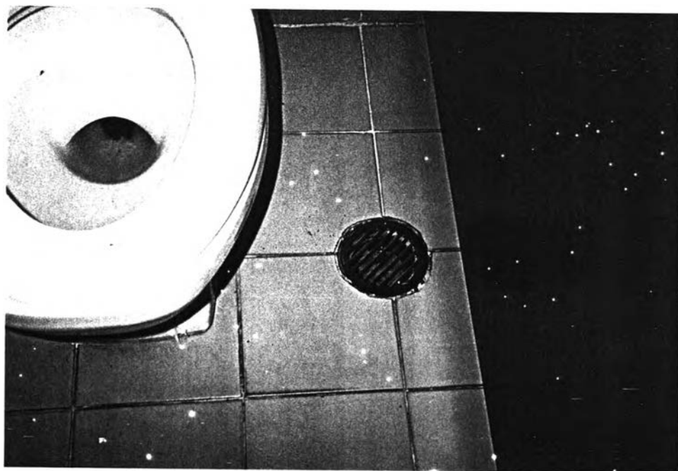
ภาพที่ 243 พื้นห้องน้ำมีระดับลาดลงไปสู่ที่ระบายน้ำ
