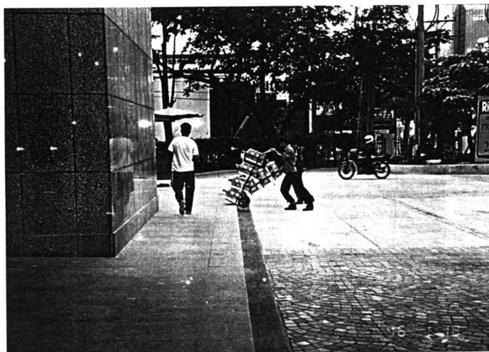
ภาพที่ 193 ขอบถนน หรือ ทางเดินบางจุดทำเป็นทางลาดสำหรับให้รถ/เก้าอี้ล้อเลื่อน ผ่านไปได้และเพื่อความสะดวกในการขนย้ายอุปกรณ์และเครื่องมือและ อำนวยความสะดวกแก่คนพิการ
