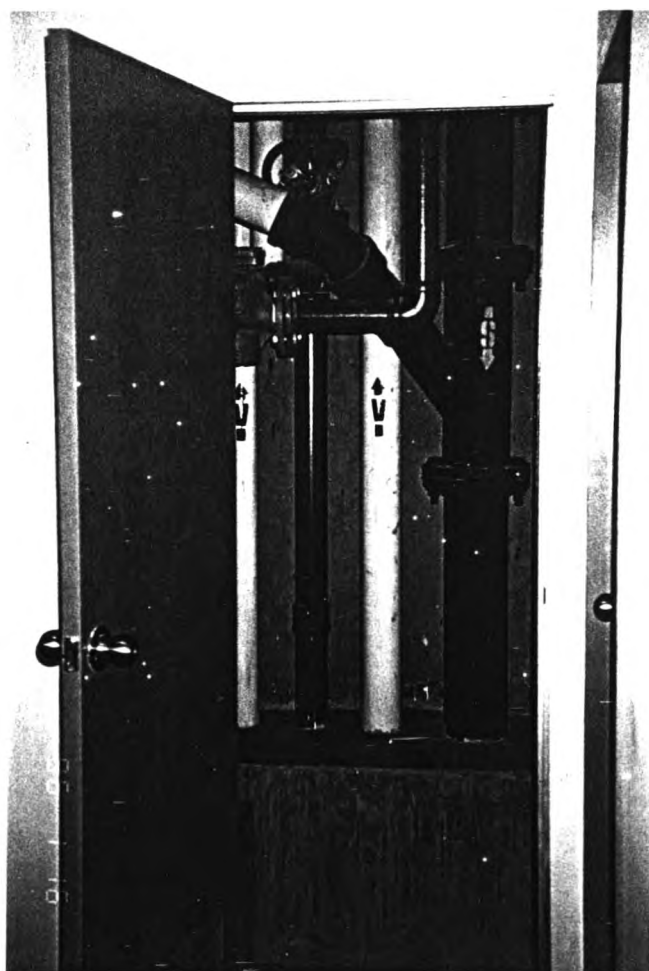
ภาพที่ 245 ท่อและอุปกรณ์ติดตั้งไว้โดยมีพื้นที่เพียงพอให้ทำการบำรุงซ่อมแซมได้สะดวก
