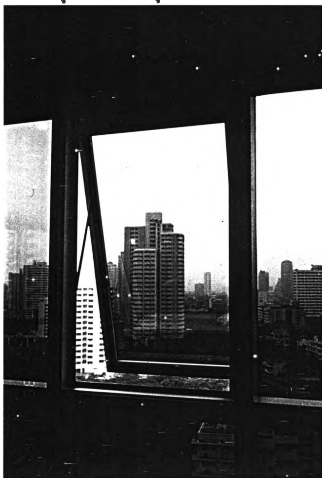
ภาพที่ 229 บานหน้าต่างเป็นกระจก กรอบเป็นอลูมิเนียม วงกบหน้าต่างเป็นอลูมิเนียม
