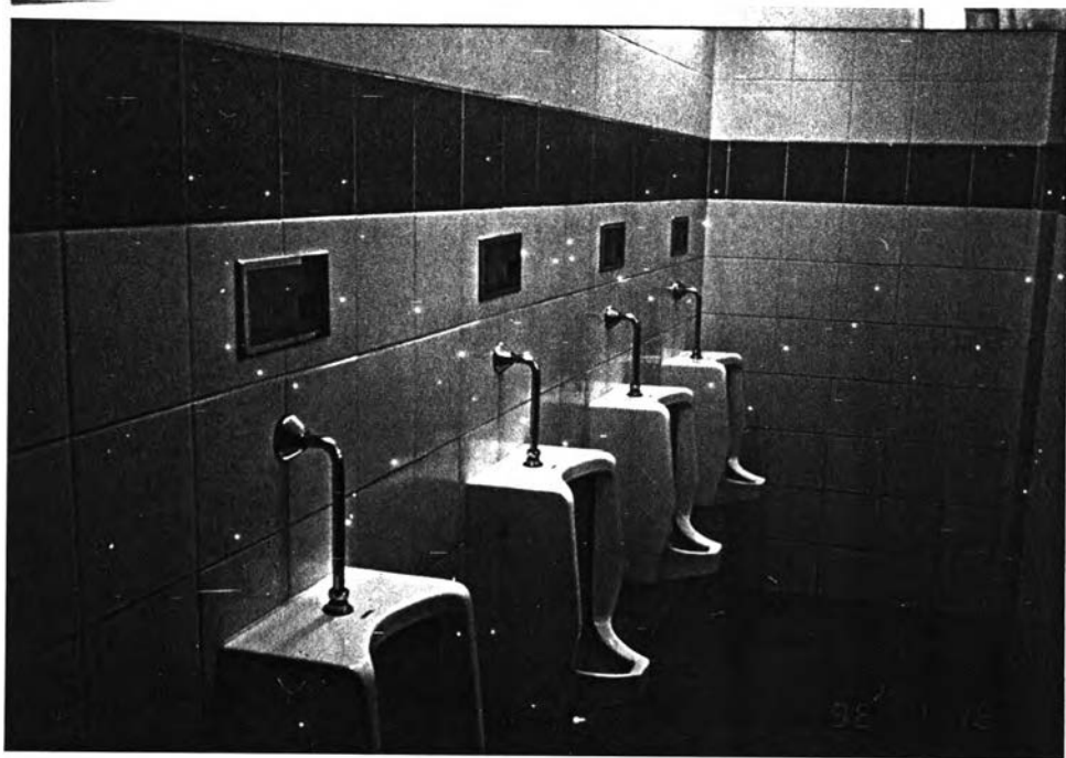
ภาพที่ 241 โถปัสสาวะมือปกรณชำระน้ำอัตโนมัติ
