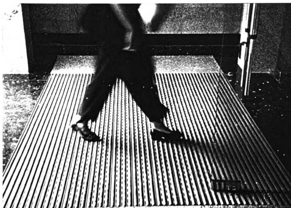
ภาพที่ 208 - มีตะแกรงและภาคโลหะฝังกับพื้นหน้าประตูทางเข้าอาคาร สำหรับรองรับฝุ่นดินทราย
