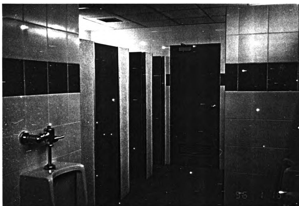
ภาพที่ 238 ผนังกันแบ่งส่วนโถอุจจาระเป็นแบบยึดติดกับผนัง หรือยึดแขวนมีขาตั้งรับกับผนัง ผนังลอยจากผนัง เพื่อทำความสะอาดผนังได้สะดวก และระบายอากาศได้ดี
