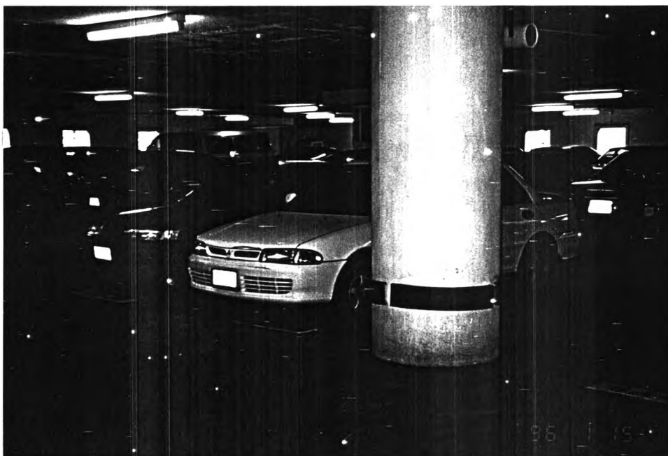
ภาพที่ 189 ส่วนที่เป็นโครงสร้างหรือตัวอาคาร ที่อยู่ใกล้กับถนนหรือทางเดินรถ มีขอบถนนหรือคั่นคอนกรีตขวางกันเพื่อป้องกันความเสียหายจากการถูกรถชน
