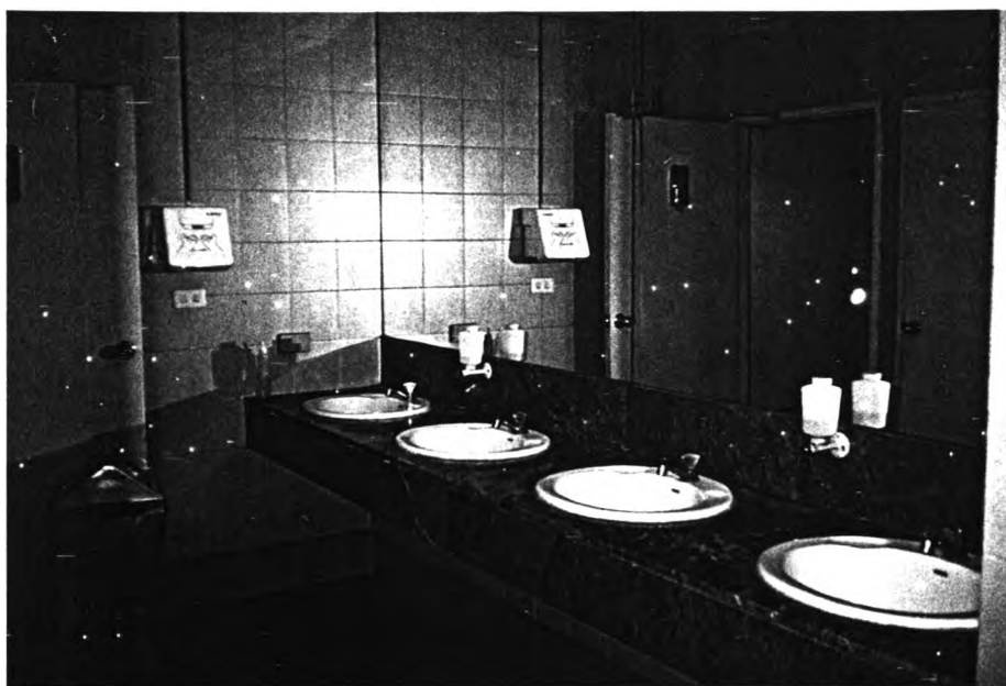
ภาพที่ 237 ผนังห้องน้ำตู้วสกระเบื้องเคลือบผิวมัน ผนังปูกระเบื้องเซรามิคผิวหยาบ ฐานแนวสี่เหลี่ยม มีอุปกรณ์จ่ายสบู่เหลวอย่างน้อย 1 ชุด ต่ออ่างล้างมือ 2 ชุด มีเครื่องเป่าลมมือให้แห้ง
