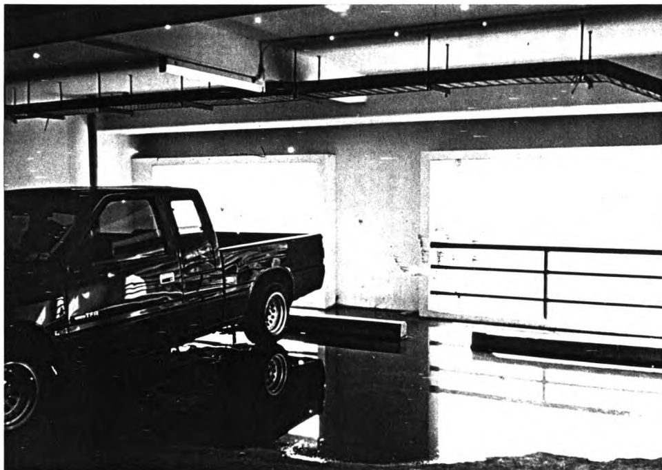
ภาพที่ 191 ผนังจุดรถและที่รับส่งของมีรางหรือท่อระบายน้ำเพียงพอเพื่อรับน้ำจาก การล้างรถและป้องกันน้ำฝนท่วมขังผนัง
