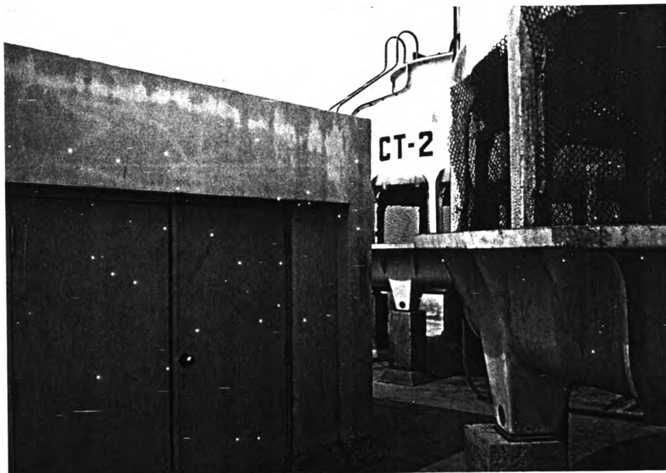
ภาพที่ 255 หอระบาศความร้อน (Cooling Tower) ไม่อยู่ใกล้กระจกหน้าต่างหรือผนังอาคาร จะทำให้น้ำกระเด็นถูกเป็นคราบได้
