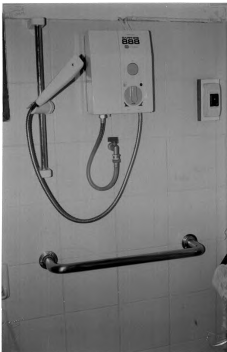
ภาพที่ 5.6 แสดงอุปกรณ์และราวจับในห้องน้ำในที่พักอาศัยโครงการที่พักอาศัยสำหรับผู้สูงอายุ
