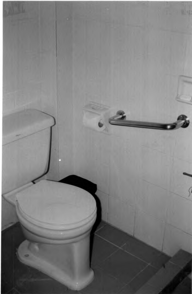
ภาพที่ 5.5 แสดงอุปกรณ์และราวจับในห้องน้ำในที่พักอาศัย โครงการที่พักอาศัยสำหรับผู้สูงอายุ
