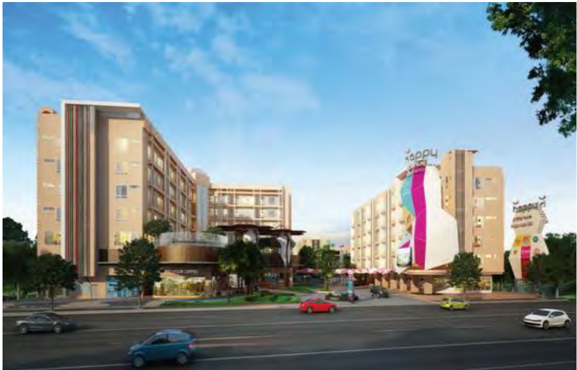
ภาพ 10 กลุ่มอาคาร North และ South โครงการ Happy Condo Ladprao 101
