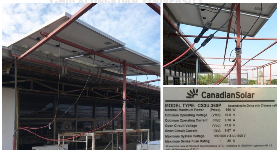
ภาพที่ 35 การติดตั้งแผงโซลาเซลล์
