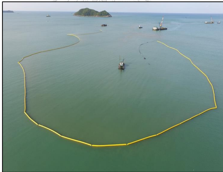
ภาพที่ 5.3 การใช้ม่านดักตะกอนในทะเล ที่มา: กรมเจ้าท่า (2564b)
