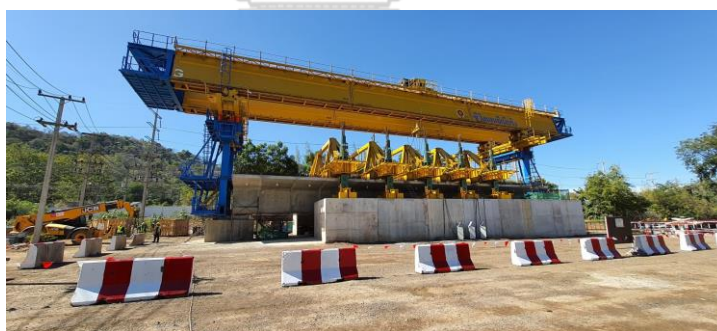
รูปที่ 4-4 โครงสร้างทางวิ่งยกระดับก่อนการทดสอบโครงสร้าง
