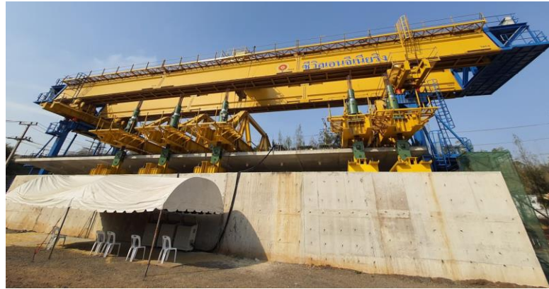
รูปที่ 3-14 ตำแหน่งการติดตั้งแม่แรงไฮดรอลิกภาคสนามในการทดสอบแรงเฉือน
