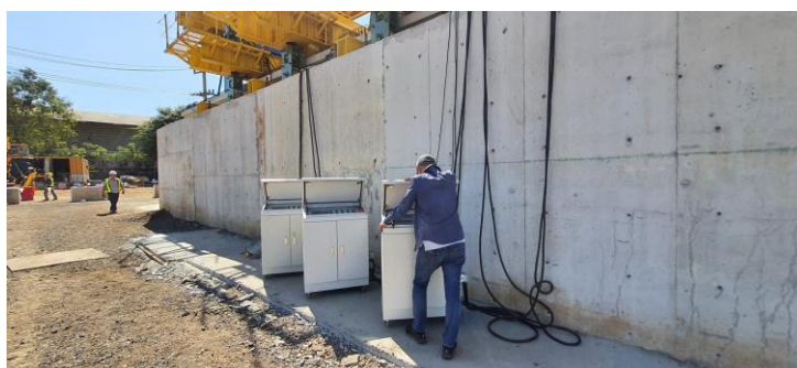
รูปที่ 4-5 เครื่องควบคุมแม่แรงไฮดรอลิก
