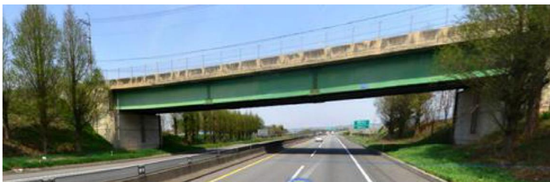
รูปที่ 2-11 สะพานโครงสร้างเหล็กช่วงพาดยาว 39 m ที่ใช้งานวิจัย (Park et al., 2017)
