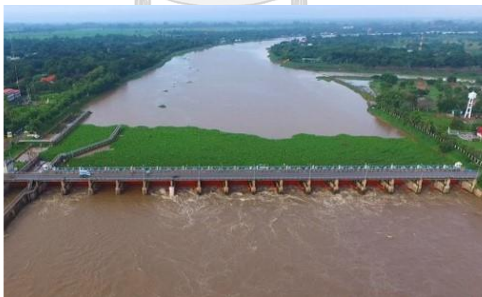
รูป 1-2 การระบายน้ำที่มีผักตบชวาลอยบนผิวน้ำผ่านประตูน้ำเขื่อนเจ้าพระยา
