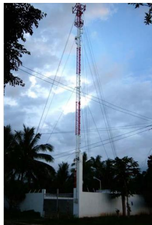
รูปภาพที่ 2 เสาโทรคมนาคมแบบ Guyed Tower 66
