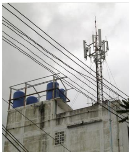
รูปภาพที่ 3 เสาโทรคมนาคมแบบ Guyed Mast 67
