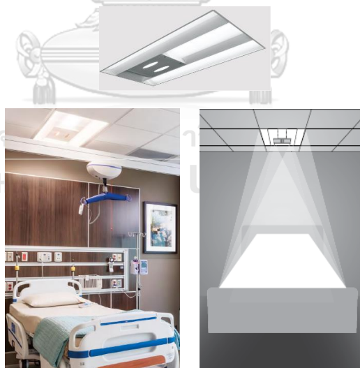
ภาพที่ 3.15 กรณีศึกษาการใช้ดวงโคมแบบผสม (multi-function) จากบริษัท H.E.William ที่มา: H.E. Williams, 2019
