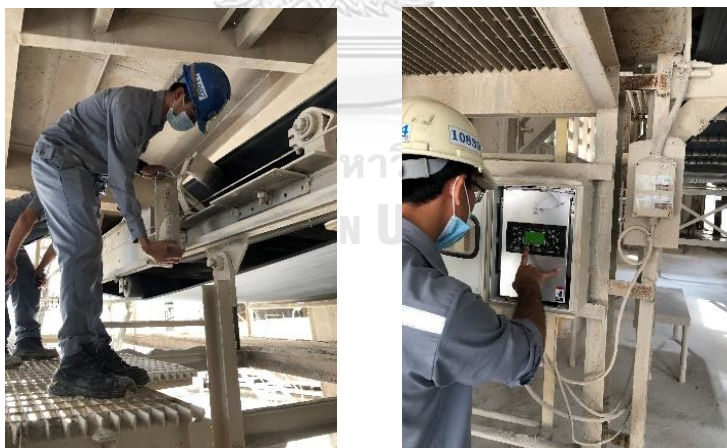
ภาพที่ 4.15 การสอบเทียบเครื่องชั่งแบบสายพานโดยหน่วยงานซ่อมบำรุง
