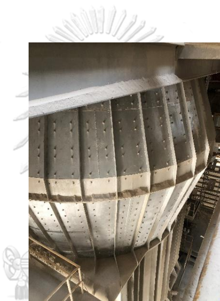
ภาพที่ 4.9 อุปกรณ์คัดแยกขนาดที่ติดตั้งอยู่เหนือห้องบดวัตถุดิบ
