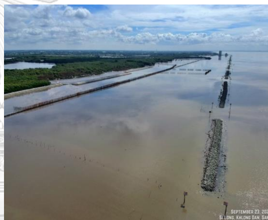
รูป ก-10 เขื่อนกั้นคลื่นจมน้ำด้านตะวันออกของ บ้านสีลัง
