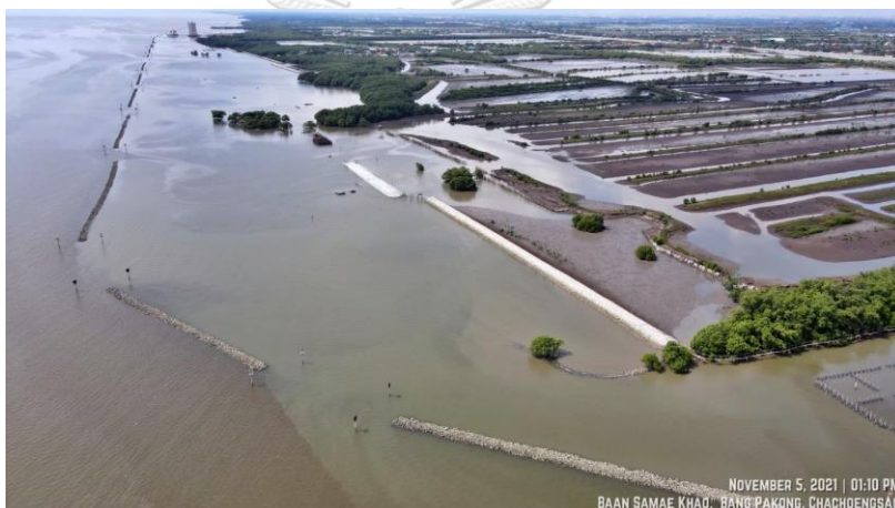
รูป ก-17 สภาพแนวชายฝั่ง และโครงสร้างป้องกันชายฝั่งด้านตะวันตกของบ้านแสมขาว
