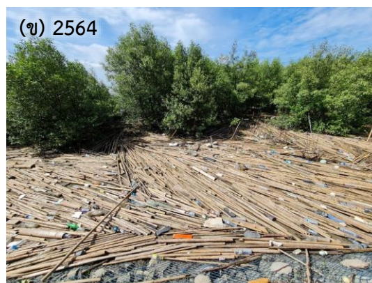
ข) ซากไม้ไผ่ชะลอคลื่นฝั่งตะวันตกของบ้านสีลัง
