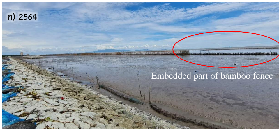
ก) การปักไม้ไผ่ชะลอคลื่นที่ด้านตะวันออกของบ้านสีลัง ระหว่าง Sta.28+540–Sta.29+500
