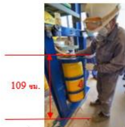
รูปที่ 30 ตำแหน่งวาล์วจุดพลิกถังคลอรีน
