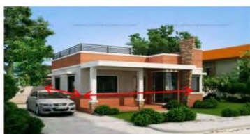
- วัดฟาด้านบน ไม่ต้องวัด ให้วัด ตามขนาดของตัว อาคาร
