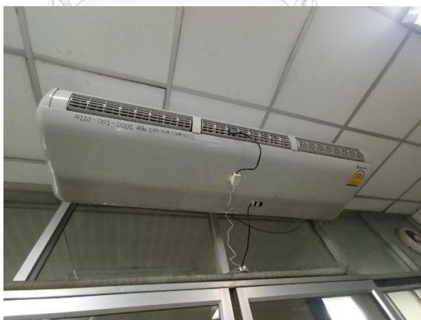
รูปที่ 27 การติดตั้ง Data logger สำหรับเก็บข้อมูลอุณหภูมิและความชื้นของเครื่องปรับอากาศ
