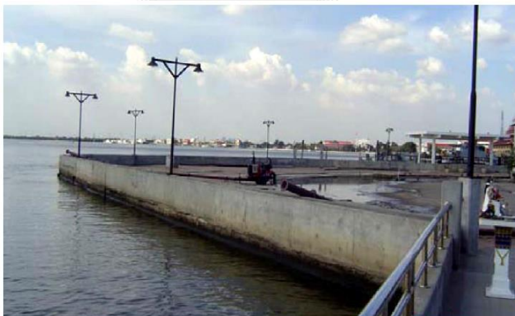
ภาพที่ 4 คันกั้นน้ำถาวรแบบคอนกรีต พร้อมเครื่องสูบน้ำ (กรมโยธาธิการและผังเมือง, 2550)
