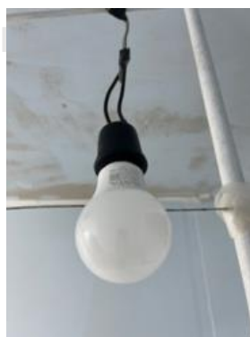
ภาพที่ 29 หลอดไฟ LED (Light-emitting diode) ขนาด 5 วัตต์ 10 วัตต์และ15 วัตต์ ยี่ห้อ EVE รุ่น Super save A60 E27)
