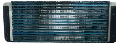
ภาพที่ 30 คอยล์เย็นที่ถอดหน้ากากครอบแอร์ออก (Fan Coil Unit (Fanless))
