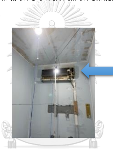
ภาพที่ 34 เครื่องปรับอากาศ ณ ระดับ D (+2.13 ม.) ระดับเหนือศีรษะ โดยวัดจากขอบล่างเครื่อง
