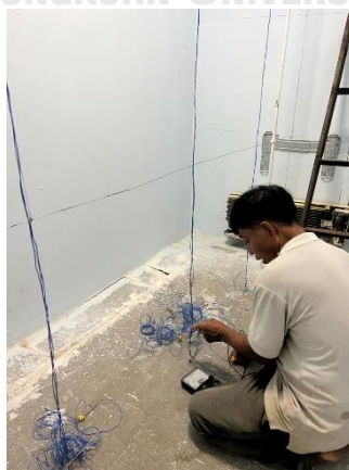
ภาพที่ 35 การติดตั้งเส้นเซอร์วัดอุณหภูมิ
