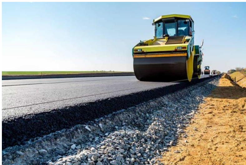
รูปที่ 1 การบดอัดวัสดุโครงสร้างทาง
