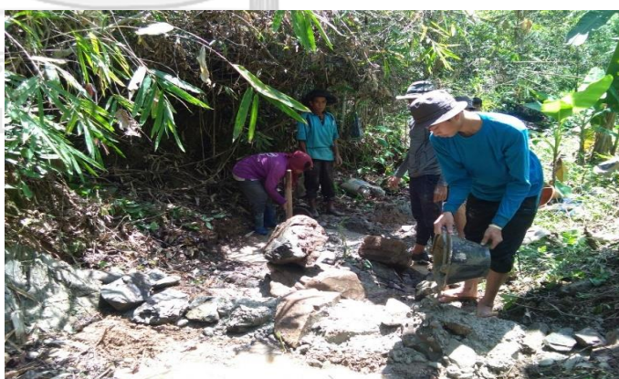
ภาพที่ 14 ภาพการสร้างฝายชะลอน้ำ (ที่มา: โครงการน้ำพางโมเดล, 2565)
